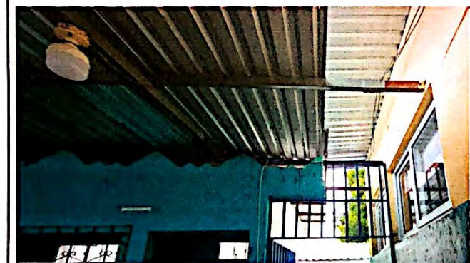
Foto 11: Cambio e instalación de lamina duralita por lamina troquelada aluzinc calibre 26 (incluye pernos) en el módulo de aulas, finalizada al 100%.
