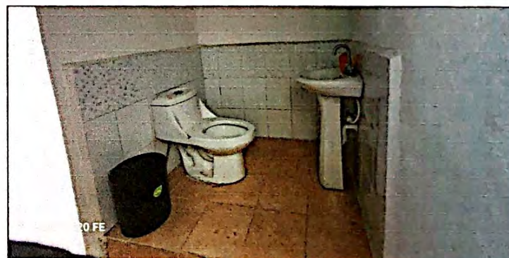
Foto 10: Mejoramiento en el baño de docentes, cambio e instalación de lavamanos y piso antideslizante finalizado al 100%
