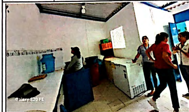
Foto 7: Mejoramiento de cocina (modulo 5.20 m x 5.40 m) incluye remozamiento de muebles de cocina, azulejo, estufa de leña rural mas chimenea mas reparación de muros. Finalizada al 100%
