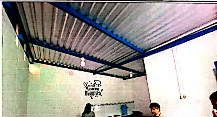
Foto 8: Cambio e instalación de estructura de soporte metal por metal y de lamina por lamina troquelada aluzinc calibre 26 (incluye pernos) en el módulo de cocina y tienda. Finalizada al 100%
