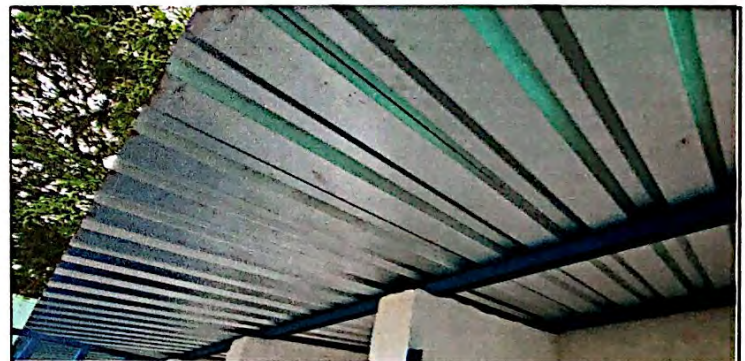
Foto 4: Cambio e instalación de estructura de soporte metal por metal y lamina por lamina troquelada aluzinc calibre 26 (incluye pernos) en el 2do módulo de baños. Finalizado al 100%
