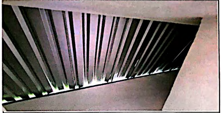
Foto2: Cambio e instalación de lamina por lamina troquelada aluzinc calibre 26 (incluye pernos) en el 1er módulo de baños. Finalizado al 100%
