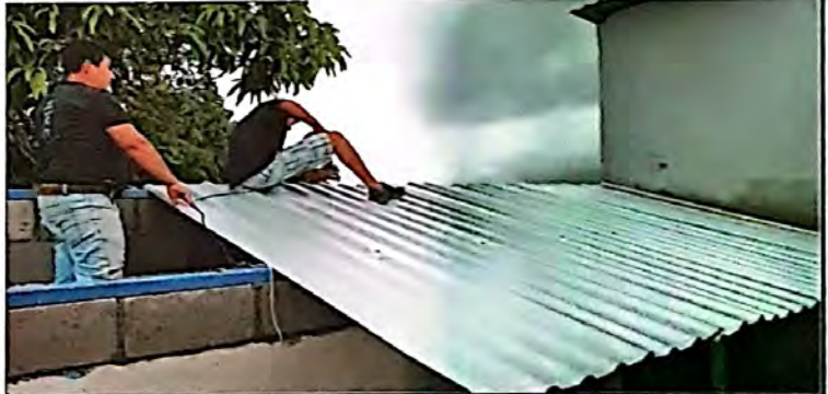
Foto 4: Suministro e intalación de estructura de lamina troquelada aluzinc calibre 26.
