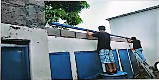
Foto 3: Sustitución de estructura de soporte metal por metal según región 1.1 PRA-FOR-85.
