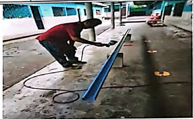
Foto2: Aplicación de pintura anticorrosiva en estructura metalica para cubierta.
