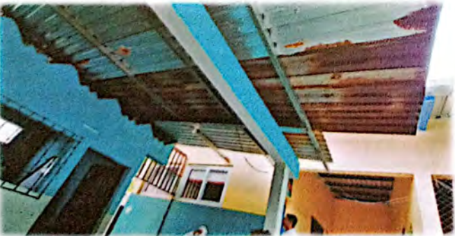
Foto 11: Mejoramiento de aulas con cambio e instalación de lámina por lámina troquelada aluzinc calibre 26 (incluye pernos).
