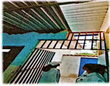
Foto 12: Las aulas aún tienen lámina estructural de perval "V"
