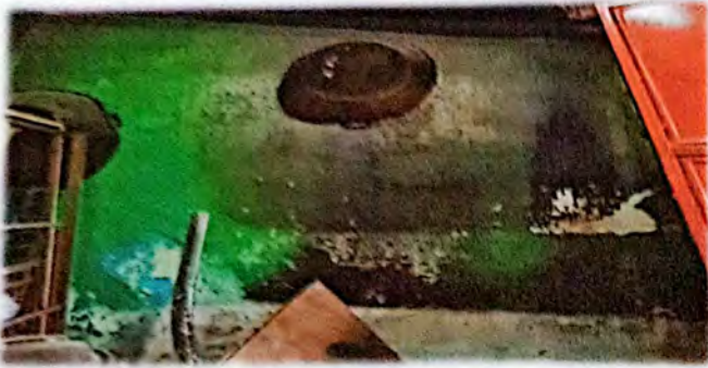
Foto 7: Mejoramiento del módulo de cocina con pintura interior y exterior.
