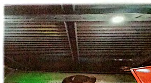
Foto 6: En cocina es necesario el cambio de la estructura de soporte de metal y cambio e instalación de lámina por lámina troquelada aluzinc calibre 26 (incluye pernos).
