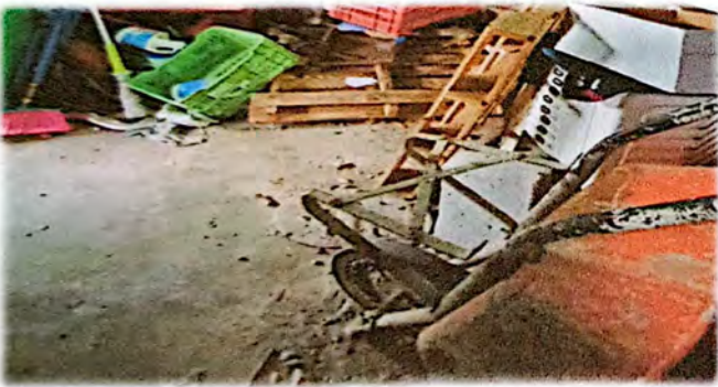
Foto 9: Cambio e instalación de piso torta de concreto y cambio e instalación de piso cerámico en módulo de cocina.
