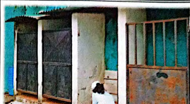
Foto 2: Mejoramiento en el 1r. módulo de servicios sanitarios. En este modulo se debe cambiar e instalar la estructura de soporte y cambiar lámina por lámina troquelada aluzinc calibre 26 (incluye pernos).
