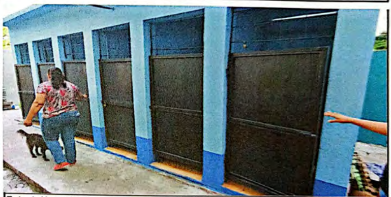
Foto 4: Herrería. Reparación y mantenimiento de puerta de metal 0.80 m x 1.5 m en el módulo de baños. Finalizado al 100%
