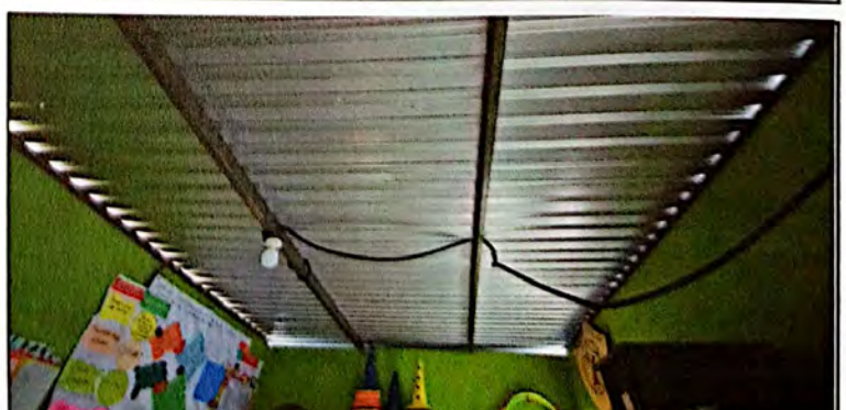
Foto 6: Cambio e instalación de lamina por lamina troquelada aluzinc calibre 26, incluye tornillos en primer módulo de aulas más dirección. Finalizado al 100%
