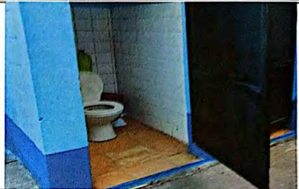
Foto 2: Mejoramiento de servicios sanitarios, incluye reparación cambio de tubería, artefactos, grifos y azulejo. Finalizado al 100%
