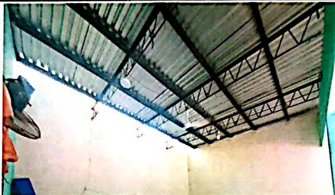
Foto 7: Suministro e instalación de lamina troquelada Aluzinc calibre 26 (incluye tornillos) en módulo de aulas, finalizado al 100%
