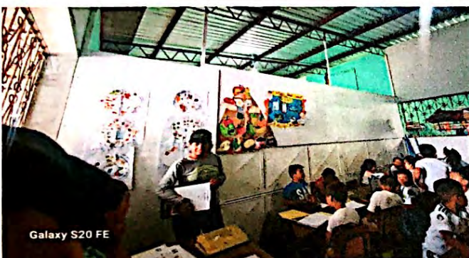
Foto 9: Sustitución de muro divisor de aula prekinder y kinder, finalizado al 100%
