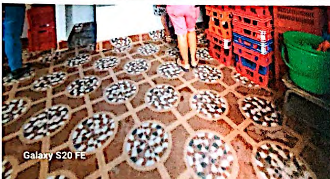
Foto 3: Sustitución de piso de concreto a piso cerámico antideslizante en el módulo de cocina, finalizada al 100%
