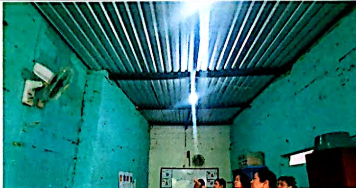
Foto 8: Suministro e instalación de lamina troquelada Aluzinc calibre 26 (incluye tornillos) en módulo de aulas, finalizado al 100%
