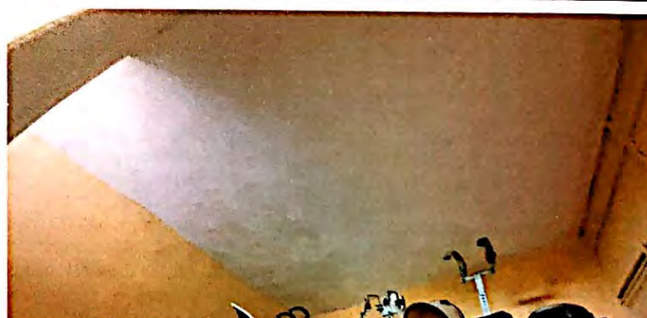
Foto 6: Reparación de losa tradicional en bodega, finalizada al 100%
