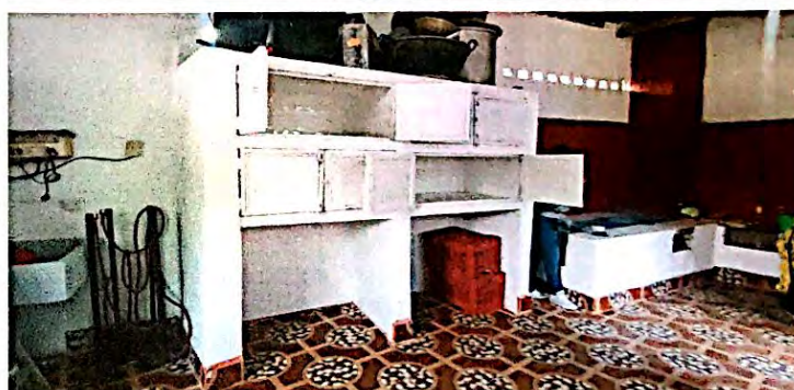
Foto 4: Herrería, sustitución de puertas de gabinetes y mantenimiento de balcones exteriores y puerta principal en el módulo de cocina, finalizada al 100%
