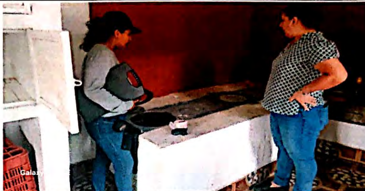
Foto 2: Sustitución de estufa de leña (incluye reparación de estufa de leña, Chimenea y plancha de metal) finalizada al 100%
