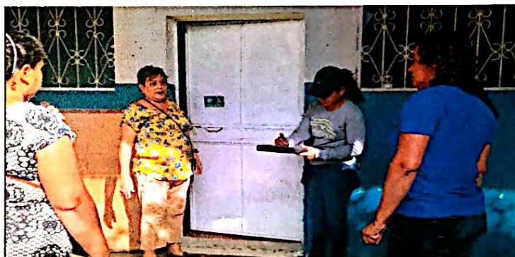
Foto 10: Herrería, mantenimiento y reparación de puerta de metal 1.00 m * 2.10 m. Finalizado al 100%
