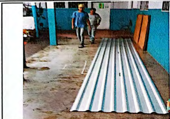
Foto 7: Laminas troqueladas Aluzinc calibre 26 en el proceso de transporte para sustituir las láminas deterioradas en uno de los módulos de aulas del establecimiento.
