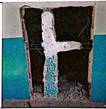
Foto 12: Derivado de la división de aulas debe crearse nuevos accesos a las nuevas áreas. Se observa el proceso de modificación de accesos.
