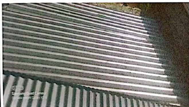
Foto 9: Lamina troquelada Aluzinc calibre 26 en el proceso de instalación.
