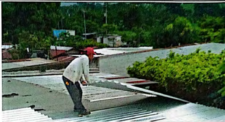
Foto 8: Suministro e Instalación de lamina troquelada Aluzinc calibre 26 ( incluye tornillos). Como los trabajos en techo no son simultaneos, puede observarse uno de los módulos durante el procedimiento de sustitución de lámina.
