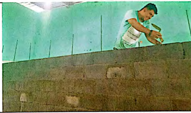
Foto 10: Sustitución de muro divisor de aula prekinder y kinder en su proceso de construcción.
