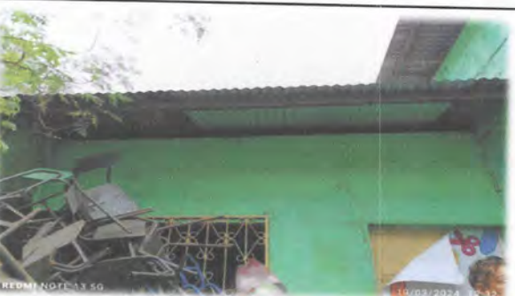
Foto 9: Sustitución de lamina ondulada por lamina troquelada aluzinc calibre 26, en modulo de aulas de 35.00 m²
