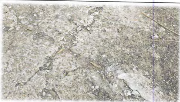
Foto 6: Foto tomada vista exterior de de grietas en losa de bodega
