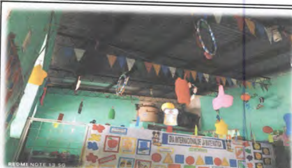
Foto 8: Sustitución de lamina ondulada por lamina troquelada aluzinc calibre 26, en modulo de aulas (interior) de 233.00 m²
