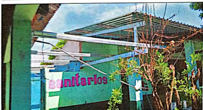
Foto 3: Proceso de suministro e instalación de estructura metalica portante en el modulo de servicios sanitarios destinados para mujeres.
