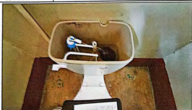
Foto 1: Proceso de avance en Cambio e instalación de accesorios de inodoros.
