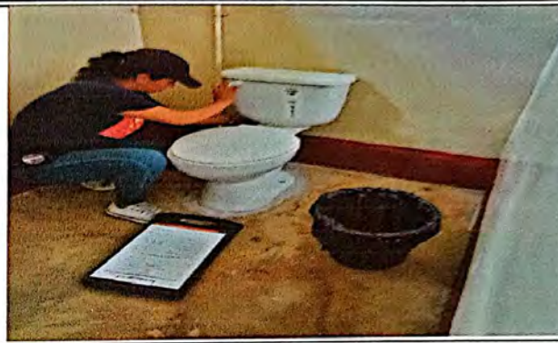
Foto 2: La evaluadora Ayary Avila supervisa la conexión de los accesorios en los servicios sanitarios.
