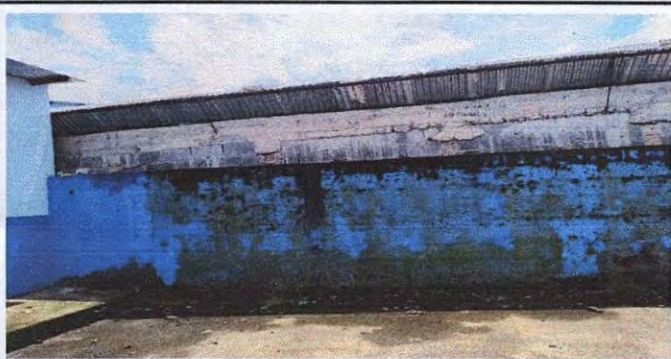
Foto 3: Sustitución de Muro Perimetral.
