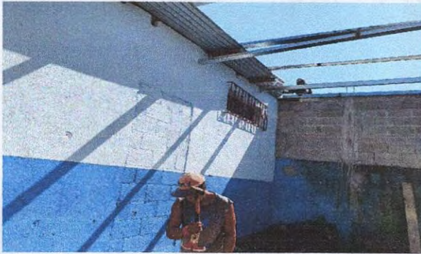
Foto1: sustitución de techo
