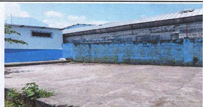
Foto 4: Sustitución de Muro Perimetral.
