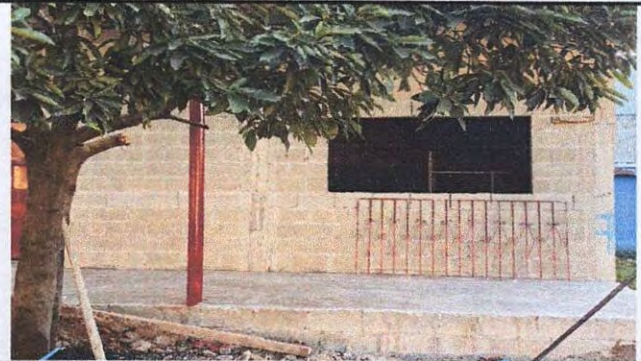
Foto 6: sustitucion de ventana balcon
