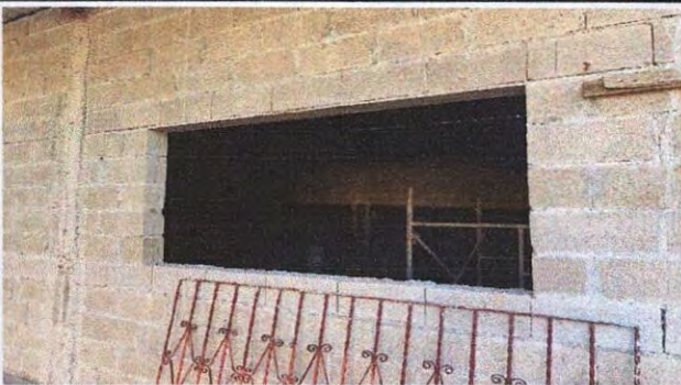
Foto 5: sustitucion de ventana balcon
