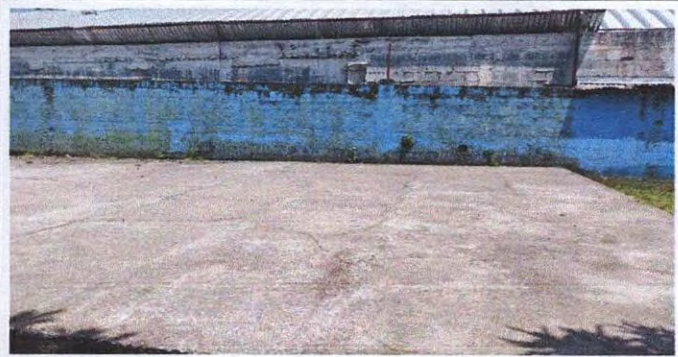
Foto 2: Sustitución de techo
