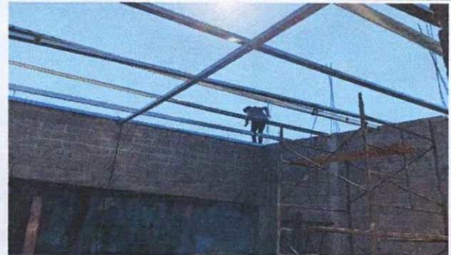
Foto 2: sustitución de techo
