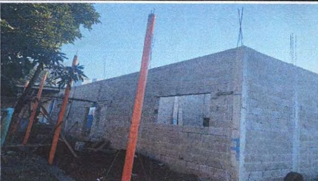
Foto 3: sustitución de muro perimetral
