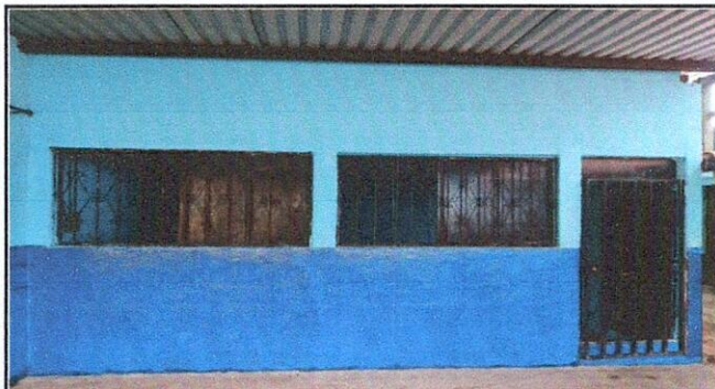
Foto 2: reparación de muro perimetral
