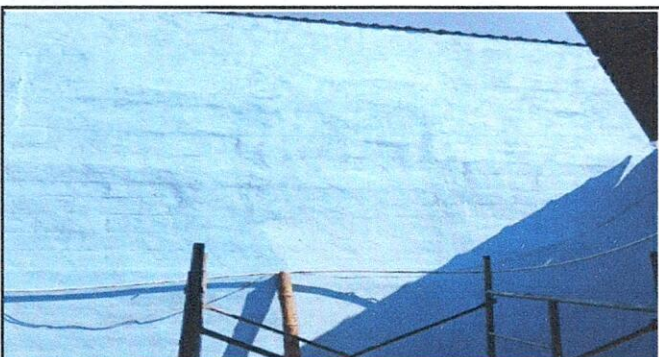
Foto 3: reparación de pañuelos
