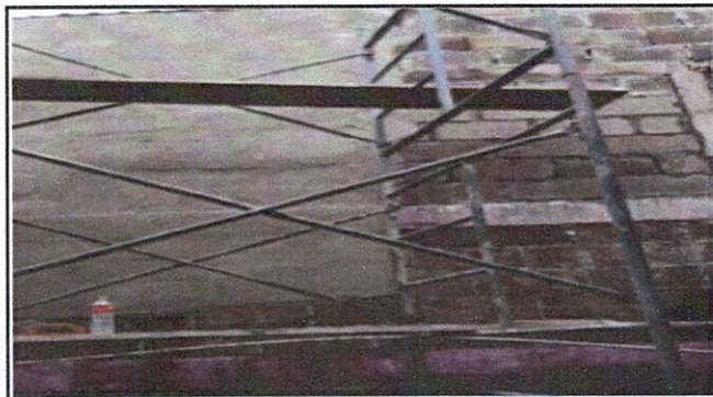
Foto 4: reparación de pañuelos
