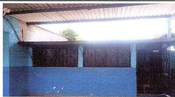
Foto 2: 15.1 Reparación de muro perimetral de Block, 7.1 Sustitución de canal de metal
