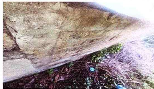
Foto 4: 3.3 Reparación de pañuelos
