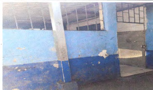
Foto 10: Paredes de aulas en pasillo
