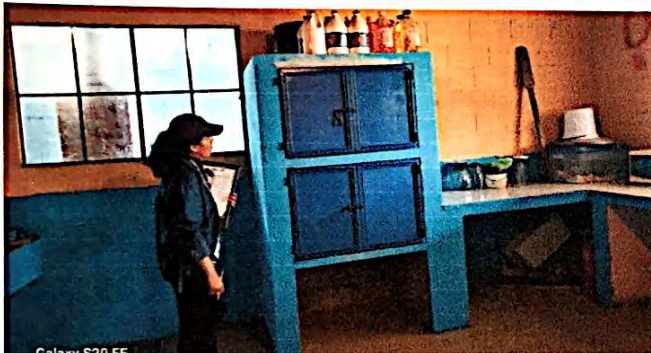
Foto 3: Mejoramiento en módulo de cocina, incluye reparación de muebles de cocina mas azulejo, colocación de puertas metálicas en gabinetes. Finalizado al 100%
