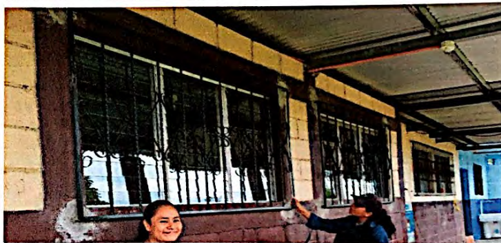
Foto 10: Instalación de balcones para ventanas en módulo de 4 aulas + salón de computo, finalizado al 100%.
