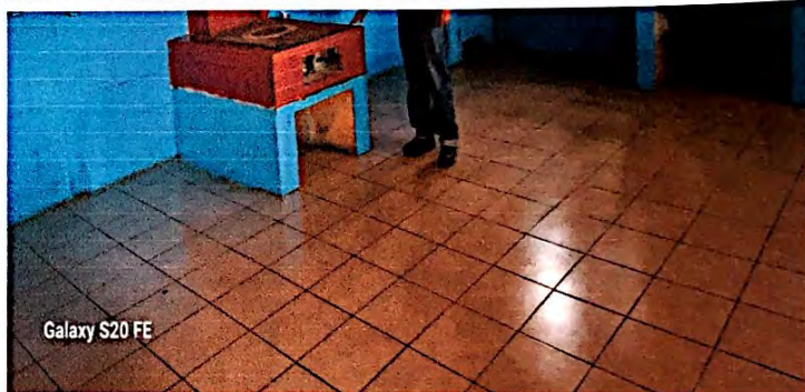
Foto 4: Sustitución e instalación de piso cerámico antideslizante en el módulo de cocina, finalizado al 100%
