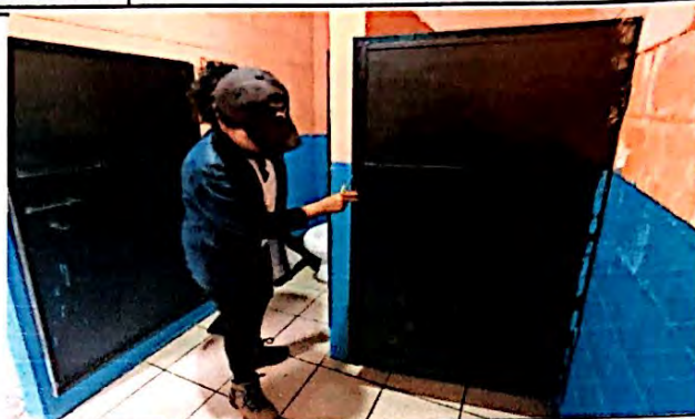
Foto 8: Mantenimiento y reparación de puertas 1.00 m x 2.18 m (Lijado, pintado y sustitución) finalizado al 100%.
