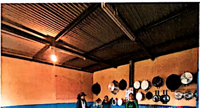
Foto 5: Suministro e instalación de estructura de soporte madera por metal (incluye tornillos) en el módulo de cocina, finalizado al 100%.
