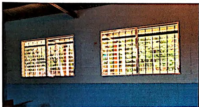
Foto 9: Cambio e instalación de ventana de aluminio mill finish mas paleta en módulo de 4 aulas + salón de computo. Finalizado al 100%
