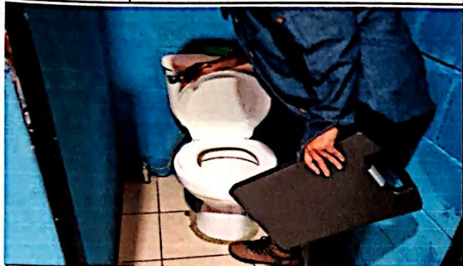
Foto 7: Sustitución de inodoros quebrados y deteriorados en el módulo de baños, finalizada al 100%.
