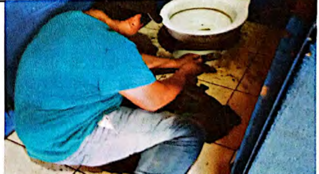
Foto 6: Sustitución de piso torta de concreto a piso cerámico antideslizante 1.20 m x 6.7 en el módulo de baños. Observese el proceso de instalación.
