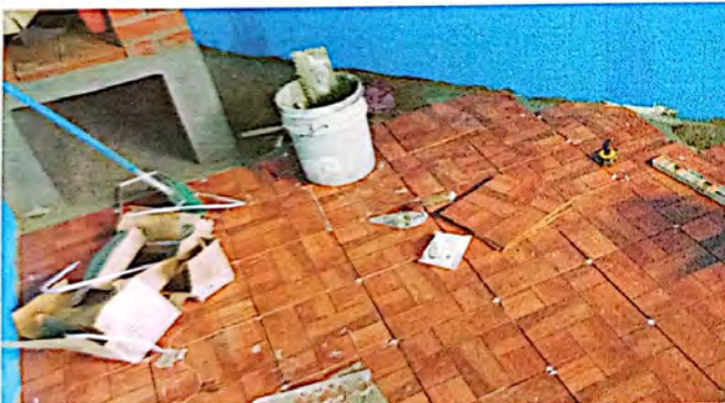
Foto 3: Sustitución e instalación de piso cerámico antideslizante en el módulo de cocina, en proceso.
