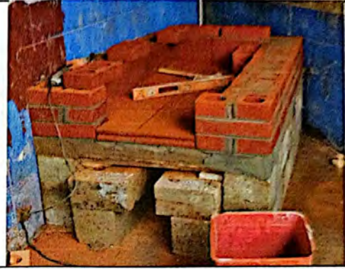
Foto 2: Reparación de dos estufas de fuego más chimenea, reparación de muebles de cocina mas azulejo en el módulo de cocina.
