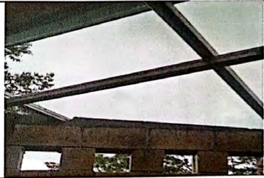
Foto 4: Suministro e instalación de estructura de soporte madera por metal (incluye tornillos) en el módulo de cocina del establecimiento.
