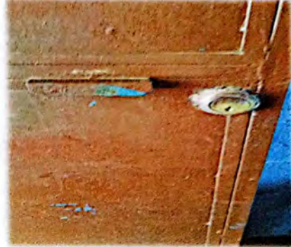
Foto 8: Reparación e instalación de dos chapas en el modulo de aulas generales.
