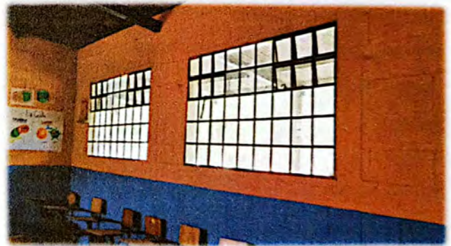
Foto 10: Sustitución e instalación de ventana actual a ventana de aluminio mill finish mas paleta de vidrio, lado frontal del modulo de aulas.
