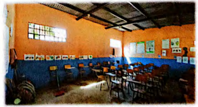
Foto 12: Sustitución e instalación de piso ceramico antideslizante 49.50 m² en el área del modulo general de aulas.
