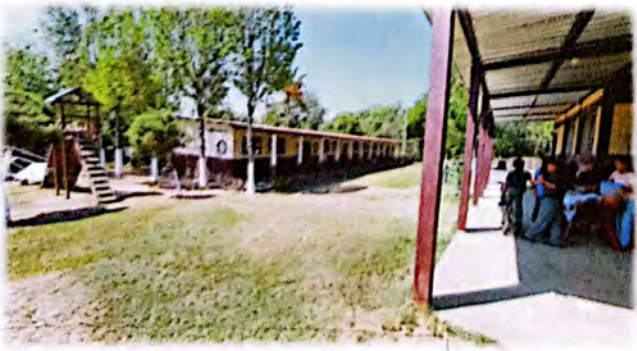
Foto 11: Sustitución e instalación de balcones. Actualmente estos salones no cuentan con balcones, lo que afecta en la seguridad del mismo.
