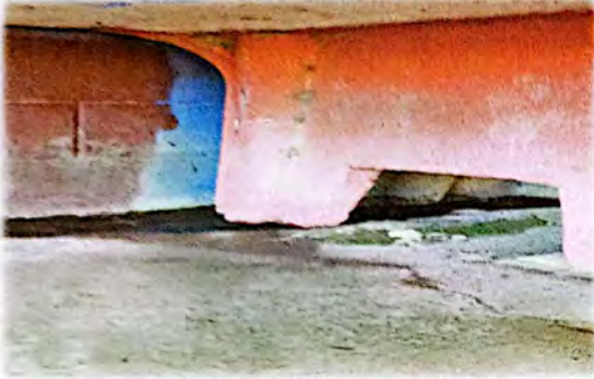
Foto 7: Reparación de servicios Sanitarios, (niñas, niños y docentes). Reparación de drenaje en pila del área de servicios sanitarios.
