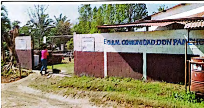
Foto 5: Suministro e instalación de estructura de soporte madera por metal (incluye tornillos) y suministro e instalación de lamina troquelada aluzinc calibre 26. Lado Externo
