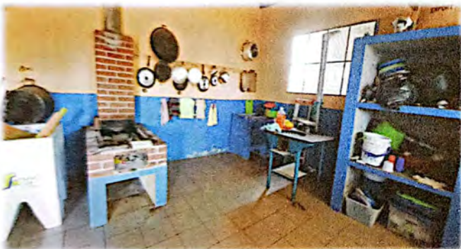
Foto 3: Modulo de Cocina, actualmente se encuentra con deficiencia en el área, se remozarán distintos trabajos. Incluye sustitución de estufa de leña rural con chimenea, entre otros.
