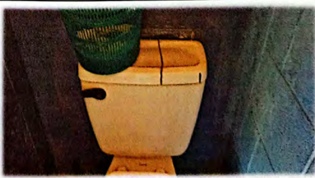
Foto 6: Se realizará cambio e instalacion de nuevos inodoros (4 unidades)
