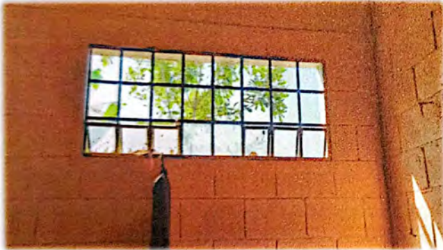
Foto 9: Sustitución e instalación de ventana actual a ventana de aluminio mill finish mas paleta de vidrio, lado posterior del modulo de aulas.
