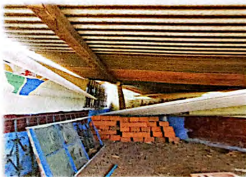
Foto 4: Suministro e instalación de estructura de soporte madera por metal (incluye tornillos) y suministro e instalación de lamina troquelada aluzinc calibre 26. Lado interno
