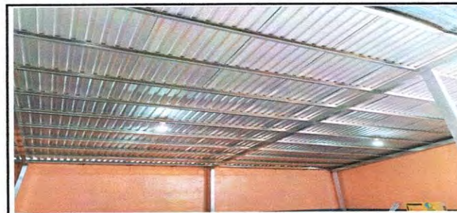
Foto 18 19.7 Instalación de estructura portante de metal Esta fotografía muestra el trabajo terminado de estructura de techo
