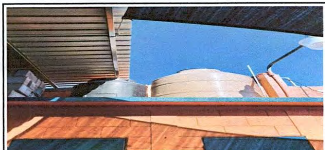
Foto 15 : 18.2 Sustitución de depósito de agua 1100lt. Esta fotografía muestra el depósito nuevo ya instalado en el lugar
