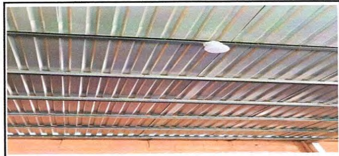
foto 12 17.5 sustitución de plafoneras plafoneras ya en uso al 100 % en el techo nuevo
