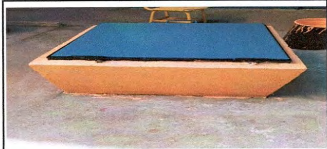
Foto 10 14.5 Reparación de tapaderas de cajas Esta fotografía muestra la elaboración de un muro para dar seguridad a la tapadera del deposito subterraneo de agua potable.
