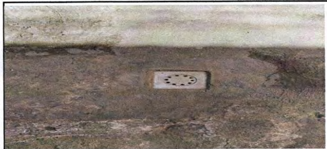
Foto 9 : 14.1 mantenimiento a reposaderas La fotografía muestra las reposaderas totalmente nuevas y reparado las caídas
