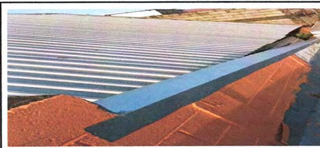
foto. 6 7.1 sustitución de canal de metal Esta fotografia muestra el canal de techo cerca de la bodega instalado cien por ciento
