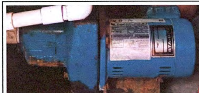
Foto 16: 18.6 reparación de bomba de agua Esta fotografía muestra la bomba ya funcionando
