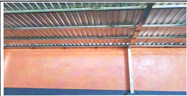
Foto 2 : 2.3 sustitución de estructura de soporte de metal, por metal soporte de metal por metal nuevo finalizado
