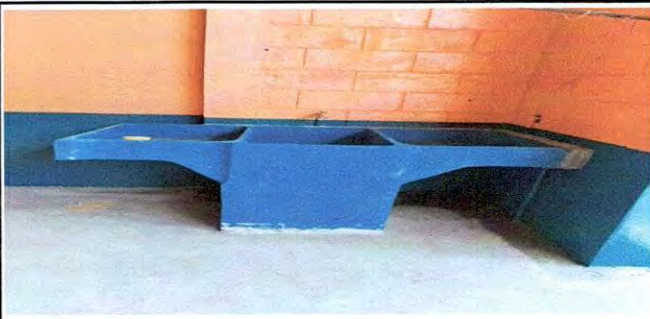
Foto 22 : 20.10 Sustitución de pila de cemento de dos lavadero Esta fotografia muestra la pila de dos lavaderos de cemento ya instalada en el espacio de juegos .
