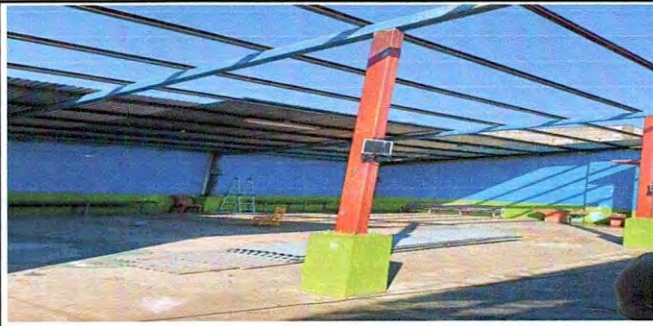
Foto1: 1.1 sustitución de lamina por lamina troqueñada aluzinc calibre 26 ( En esta fotografia se muestra el desmontaje de la lamina que se cambiara por troquelada calibra 26.)
