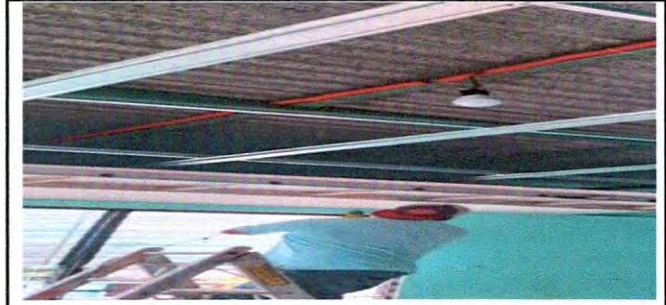
foto 12 17.5 sustitución de plafoneras ( En la fotografía se puede apreciar la colocación de plafonera en la estructura del techo
