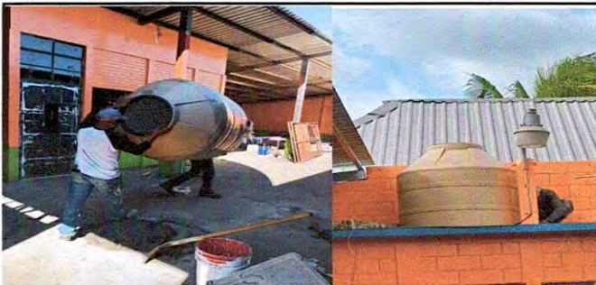
Foto 15 : 18.2 Sustitución de depósito de agua 1100lt. Esta fotografía muestra el depósito nuevo y su proceso de instalación en el lugar indicado.
