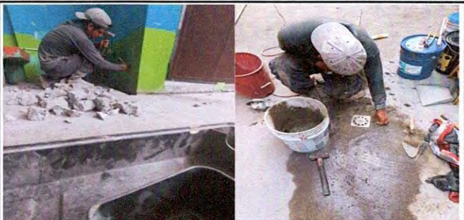
Foto 9 : 14.1 mantenimiento a reposaderas ( Esta fotografía muestra el trabajo realizado en reposaderas de drenaje y caídas de agua)
