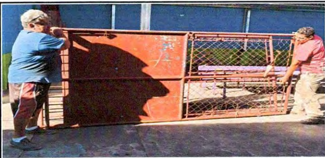
Foto 3 : sustitución de portón de metal muestra el desmontaje del portón viejito
