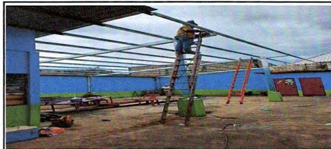
Foto 19: 19.7 Instalación de estructura portante de metal Esta fotografía muestra el trabajo de instalación de estructura de metal del techo
