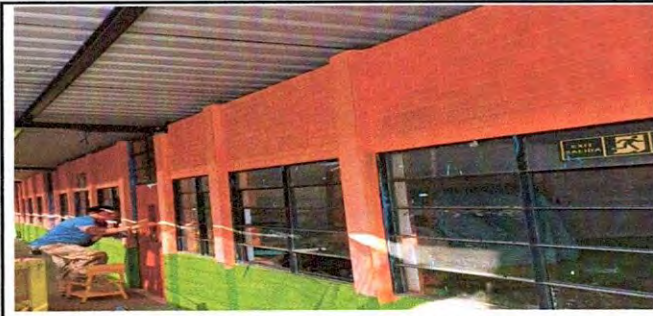
foto 4 : 5.1 mantenimiento a estrucutura de metal de ventanas Esta fotografia muestra el proceso de mantenimiento en la estructura de las ventanas de los diferentes salones .
