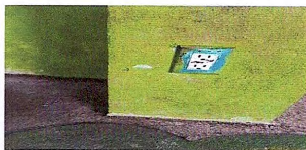
Foto 14 : 17.8 Sustitución de tomacorrientes dobles
