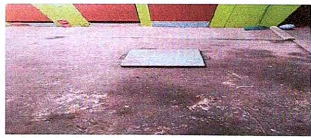
Foto10: 14.5 Reparación de tapaderas de cajas
