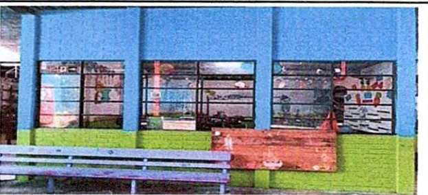
Foto 5: 5.5 sustitución de vidrios
