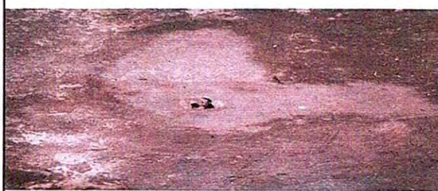
Foto 9: 14.1 Mantenimiento a reposaderas
