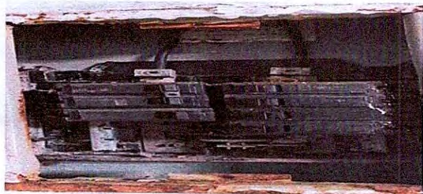
Foto 15 : 17.9 Sustitución de flipones
