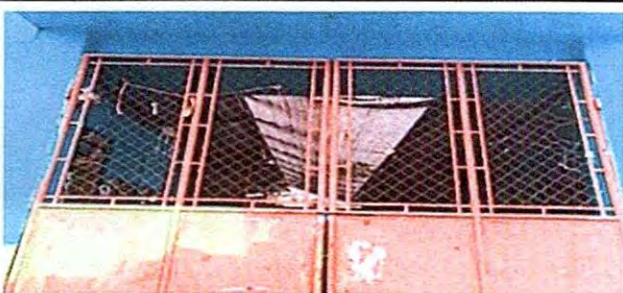
Foto 3: 4.5 Sustitución de portón de metal
