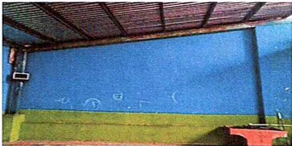
Foto 7: 9.1 Pintura en muros exteriores e interiores
