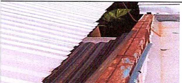
Foto 6: 7.1 Sustitución de canal de metal
