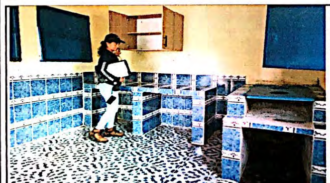
Foto 5: Mejoramiento de cocina (incluye remozamiento de estufa de leña rural, reparación de muebles de cocina y suministro e instalación de azulejo). Finalizado al 100%
