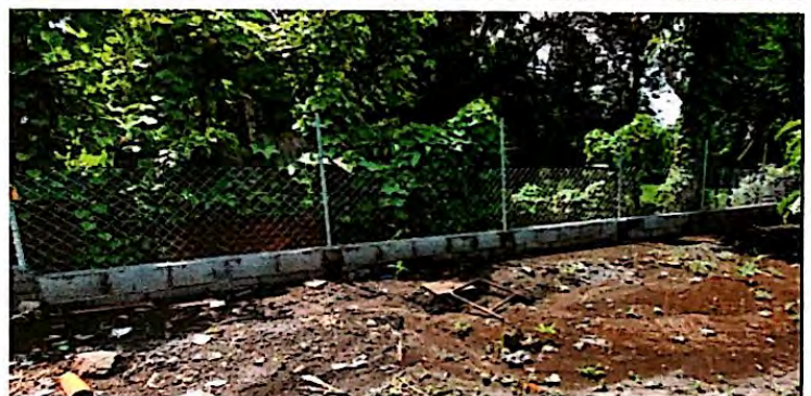
Foto 10: Reparación de muro perimetral de block con tubo hg y malla galvanizada, soleras y columnas, finalizada al 100%
