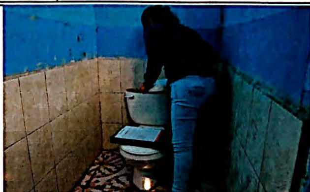
Foto 2: Cambio e instalación de kit y tapaderas para inodoros en el módulo de servicios sanitarios. Finalizado al 100%
