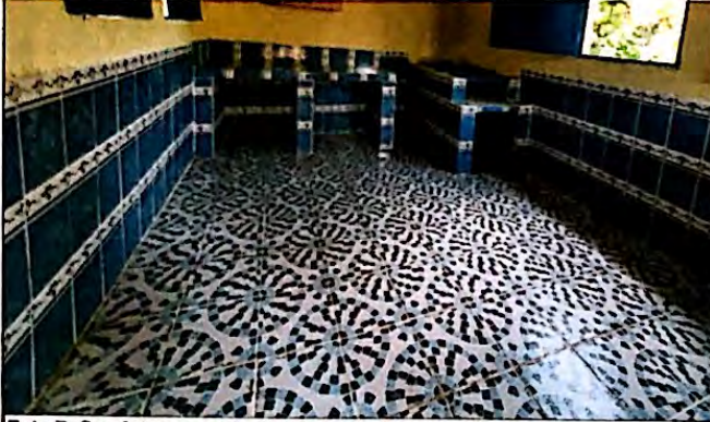
Foto 7: Sumistro y sustitución de torta de concreto por piso ceramico antideslizante en el módulo de cocina, finalizado al 100%
