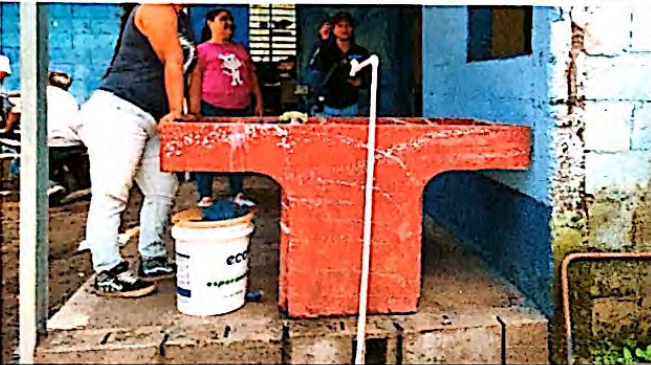
Foto 9: Cambio e instalacion de pilas de 2 lavaderos en el módulo de cocia, finalizado al 100%
