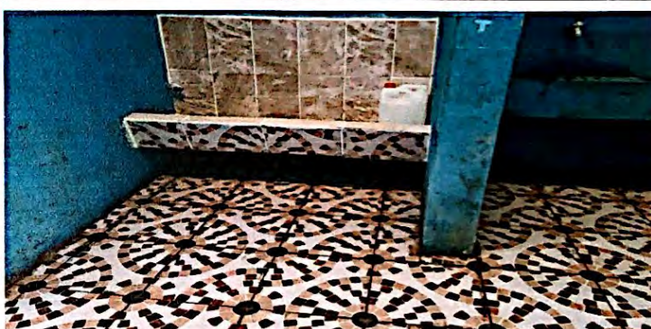
Foto 4: Sustitución de piso torta de concreto a piso cerámico antideslizante en el módulo de servicios sanitarios. Finalizado al 100%
