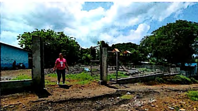
Foto 11: Reparación de muro perimetral de block con tubo hg y malla galvanizada, soleras y columnas. Finalizada al 100%
