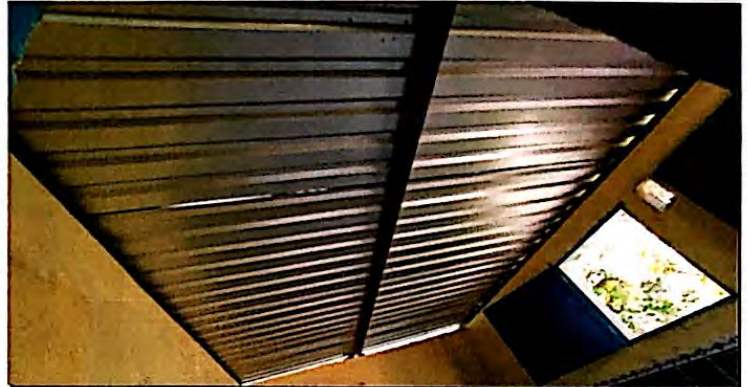
Foto 8: Suministro e intalación de lamina por lamina troquelada aluzinc calibre 26 en el módulo de cocina. Finalizado al 100%
