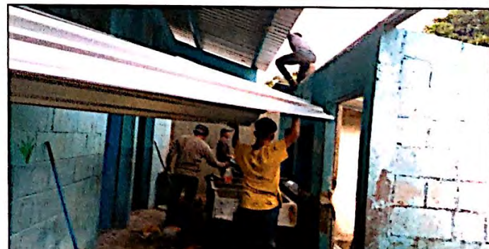
Foto 6: Se ve proceso de ejecución en suministro e instalación de lamina por lamina troquelada aluzinc calibre 26.
