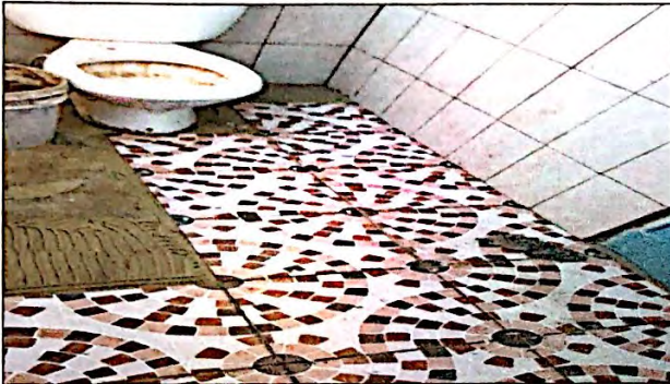
Foto 3: Se visualiza avance en la instalación de piso cerámico antideslizante en cubículos de los inodoros, en el modulo de servicios sanitarios de niños, niñas y docentes.
