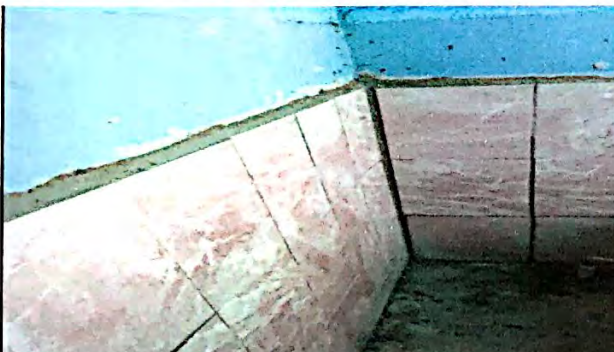
Foto 5: Se visualiza avance en la instalación de azulejo en pasillo, en el modulo de servicios sanitarios de niños, niñas y docentes.
