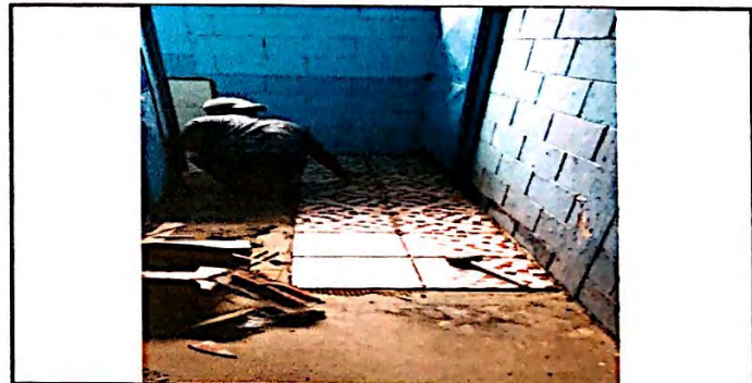
Foto 4: Se visualiza avance en la instalación de piso cerámico antideslizante en pasillo, en el modulo de servicios sanitarios de niños, niñas y docentes.
