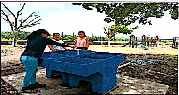
Foto 3: Evaluadora de campo inspecciona la conexión de agua potable en pilas de concreto de dos lavaderos finalizado.
