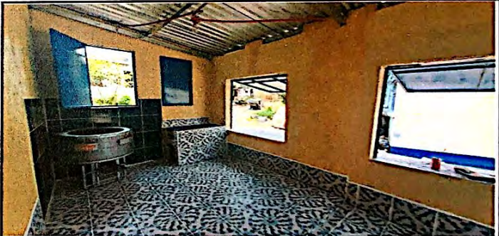
Foto 4: Mejoramiento en módulo de cocina, remozamiento de estufa de leña rural al 100% de su ejecución.
