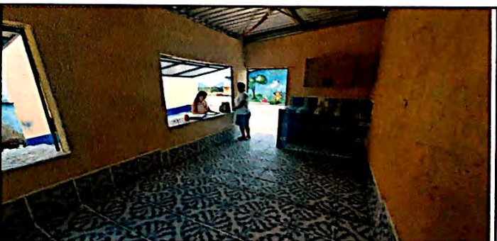
Foto 6: Sustitución de torta de concreto a piso cerámico antideslizante en el módulo de cocina finalizado al 100% de su ejecución.
