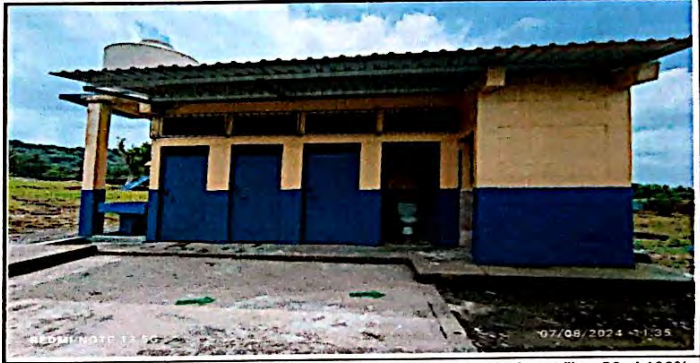
Foto 2: Suministro e instalación de lámina por lámina troquele aluzinc calibre 26 al 100% de ejecución.
