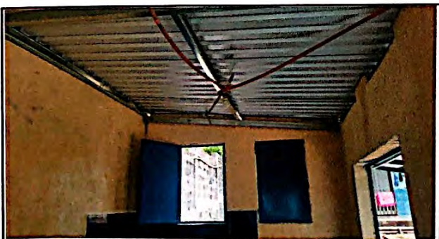
Foto 5: Instalación de la lámina troquele aluzinc calibre 26 en módulo de cocina al 100%.
