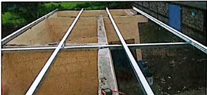
Foto 4: Suministro e instalación de estructura de soporte de madera por metal en el módulo de baños.
