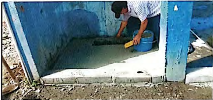
Foto 6: Suministro e instalación de pilas de concreto de 2 lavaderos y sus respectivas conexiones sanitarias e hidráulicas dentro del módulo de servicios sanitarios.
