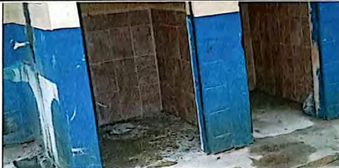
Foto 2: Cambio e instalación de inodoros en el módulo de baños. Se observa el espacio vacío de los sanitarios pues estos ya fueron retirados.
