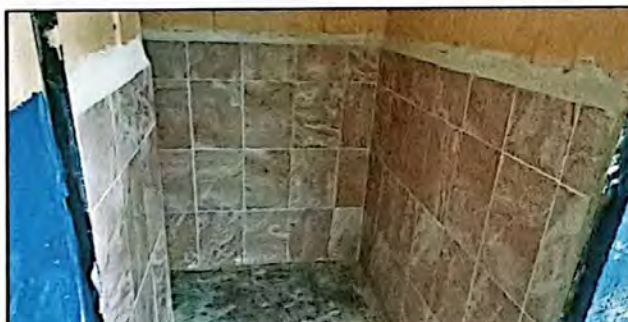
Foto 3: Suministro e instalación de azulejo en el módulo de baños en su proceso de colocación.
