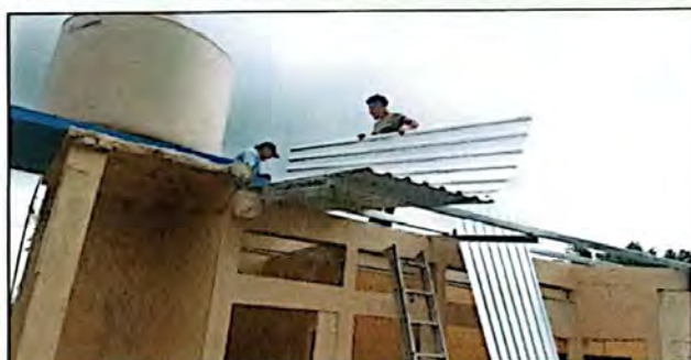
Foto 5: Suministro e instalación de lamina por lamina troquelada de aluzinc calibre 26 en el módulo de baños, se observa el inicio del proceso de instalación de lámina.
