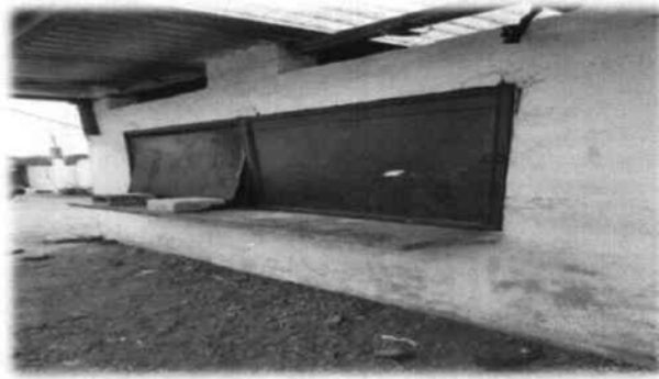
Foto 8: La cubierta de la cocina, estructura portante de madera/metal y lamina, se encuentra con deterioro, en especial la estructura de madera.
