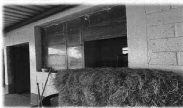
Foto 10: En el área de dirección se sustituirá la ventana actual por ventana de aluminio mill finish mas paleta de vidrio, ya que en temporadas de verano el lugar es caluroso y es necesario tener las ventanas abiertas, y las que posee actualmente algunos vidrios son fijos.
