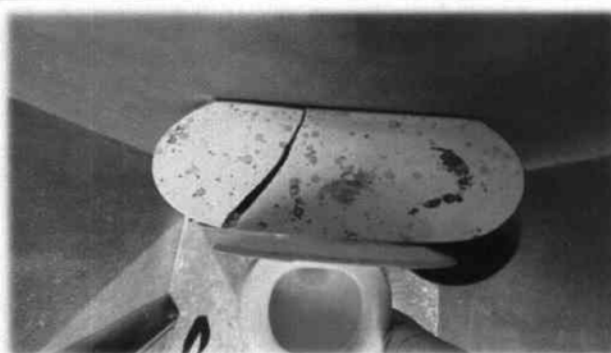
Foto 3: Actualmente se encuentran los inodoros deteriorados y quebrados, se contabilizaron cuatro unidades.
