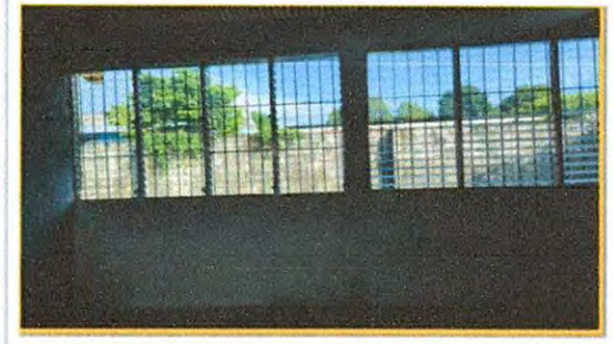
Foto 6: Sustitución de estructura de metal de ventana
