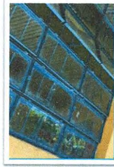
Foto 4: Sustitución de vidrios
