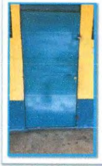
Foto 1: Mantenimiento a estructura de puertas (lijado, cambio de tubo, cepillado, sujeciones, aplicación de pintura)
