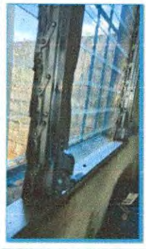
Foto 3: Mantenimiento a marcos de aluminio mill finish
