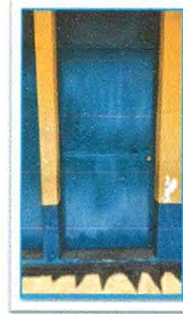
Foto 2: Mantenimiento a estructura de puertas (lijado, cambio de tubo, cepillado, sujeciones, aplicación de pintura)
