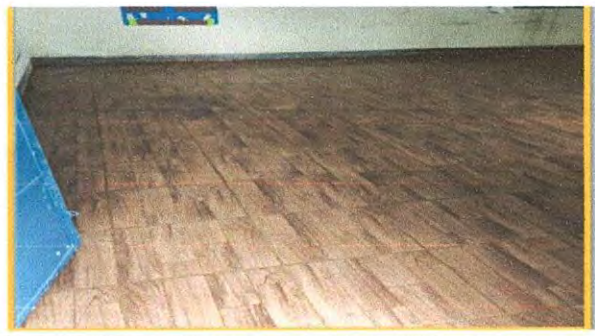
Foto 1: Sustrución de piso cerámico
