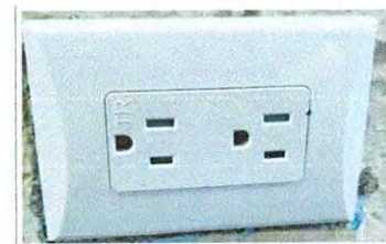
Foto 6: Sustrución de tomacorrientes dobles
