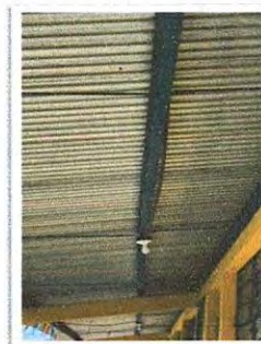
Foto 2: Reparación de cableado eléctrico
