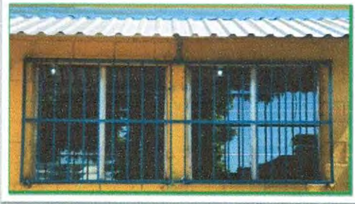
Foto 5: Sustitución de balcones de metal
