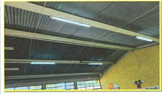
Foto 4: Sustrución de lámparas
