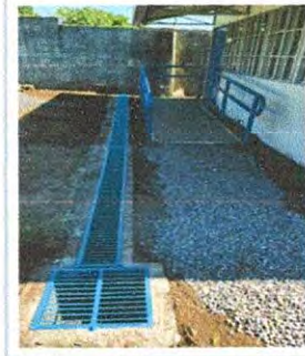
Foto 6: elaboracion de cunetas por filtracion de agua en los Modulos
