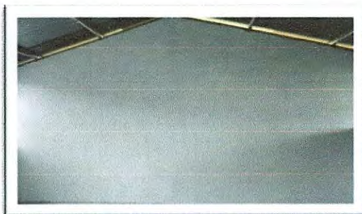
Foto 3: Repello en muro
