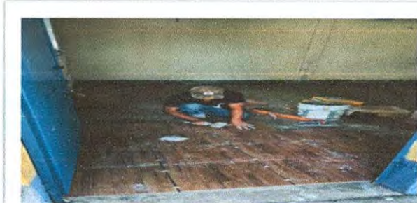
Foto1: Sustitución de piso cerámico
