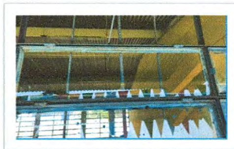
Foto 4: Sustitución de vidrios
