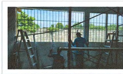
Foto 6: Sustitución de estructura de metal de ventana
