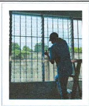
Foto 3: Mantenimiento a marcos de aluminio mill finish
