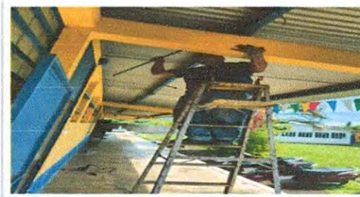
Foto 2: Reparación de cableado electrico
