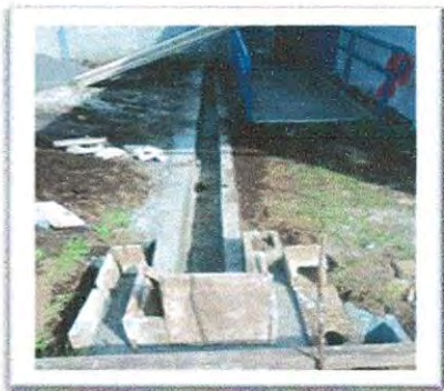
Foto 5: elaboracion de cunetas por filtracion de agua en los Modulos
