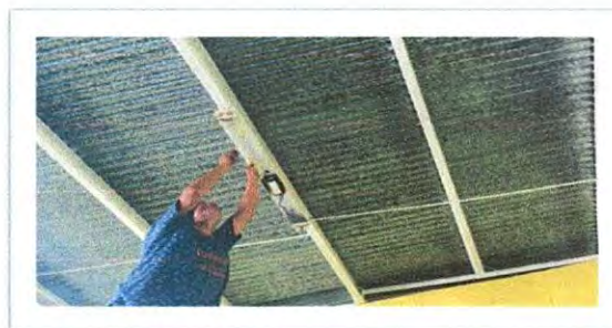
Foto 4: Sustitución de lámparas
