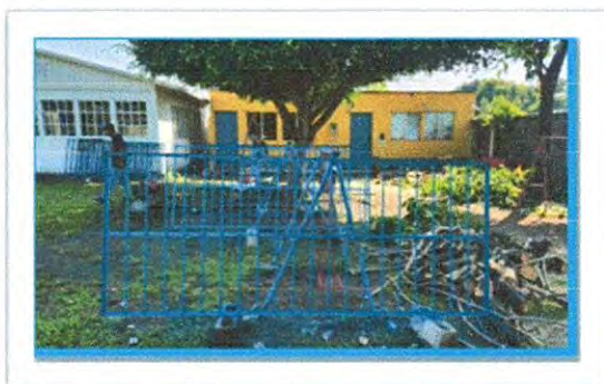
Foto 5: Sustitución de balcones de metal
