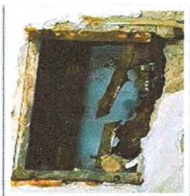
Foto 1: Sustitución de tablero de flipones
