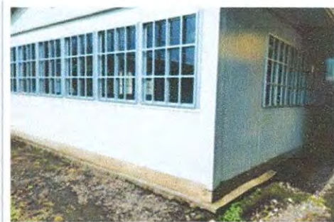
Foto 6: elaboracion de cunetas por filtracion de agua en los Modulos
