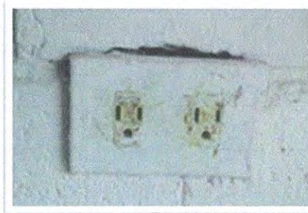
Foto 6: Toma corrientes dobles en mal estado por antigüedad
