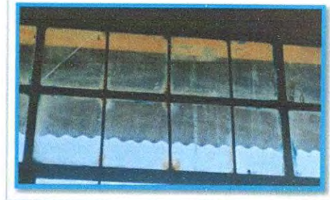
Foto 4: Cambio de vidros de quebrados
