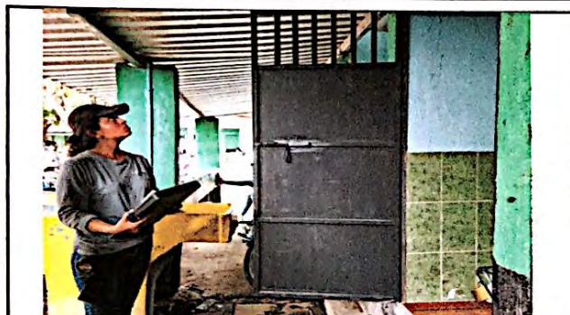
Foto 3: Herrería. Reparación y mantenimiento de puertas en módulo de baños. (2.00 m x 0.85 m). Finalizado
