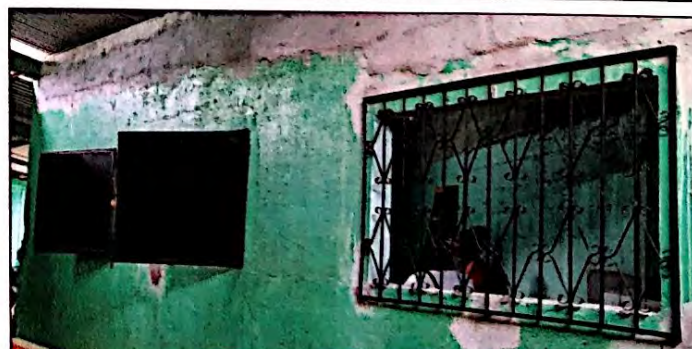
Foto 6: Herrería. Reparación y mantenimiento de puerta de metal y de reja, ventanas de metal para despacho de cocina mas balcon. Finalizado.
