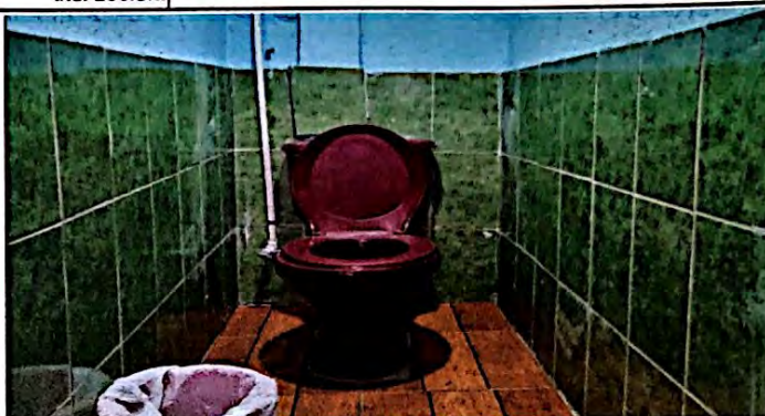
Foto 2: Mejoramiento de servicios sanitarios, incluye reparación cambio de tubería, artefactos y azulejo. Finalizado
