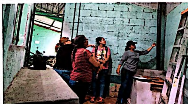
Foto 5: Reparación y mejoramiento de cocina, incluye remozamiento estufa de leña rural, y reparación de muebles fijos de concreto y azulejo. Finalizado
