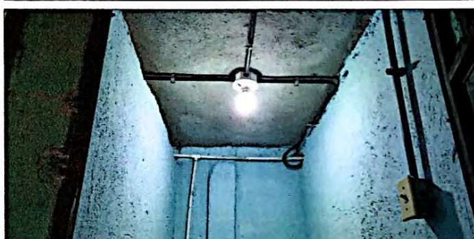
Foto 4: Reparación de circuito eléctrico iluminación en módulo de baños (incluye ducto o tubo PVC, abrazaderas, foco ahorrador de alta potencia, interruptores y cables). Finalizado
