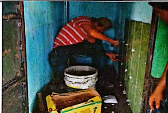
Foto 2: Mejoramiento de servicios sanitarios, incluye reparación cambio de tubería, artefactos y azulejo. Instalación de azulejos en proceso.
