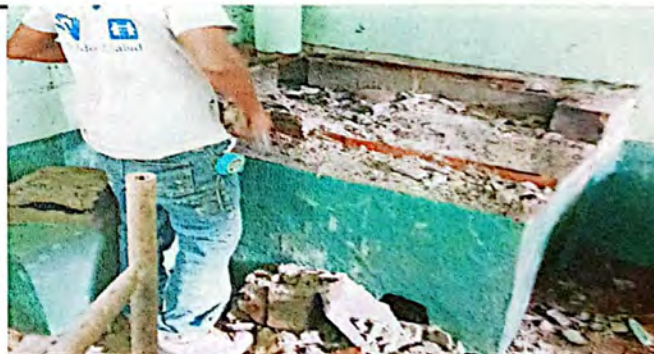
Foto 4: Reparación y mejoramiento de cocina, incluye remozamiento estufa de leña rural, y reparación de muebles fijos de concreto y azulejo. Reconstrucción de estufa de leña.
