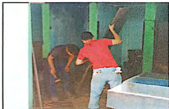
Foto 3: Herrería. Reparación y mantenimiento de puertas. (2.00 m x 0.85 m) en el módulo de servicios sanitarios. Proceso de desmoteje de puertas.
