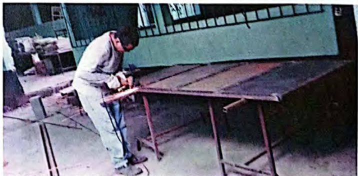
Foto 6: Herrería. Reparación y mantenimiento de puerta de metal y de reja, ventanas de metal para despacho de cocina mas balcon.
