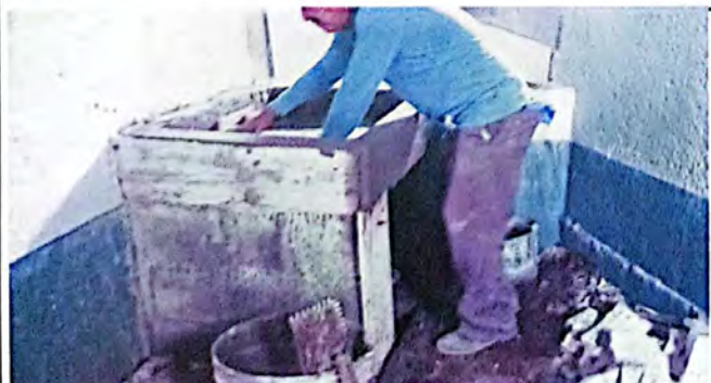
Foto 5: Reparación y mejoramiento de cocina, incluye remozamiento estufa de leña rural, y reparación de muebles fijos de concreto y azulejo. Reparación de pileta.
