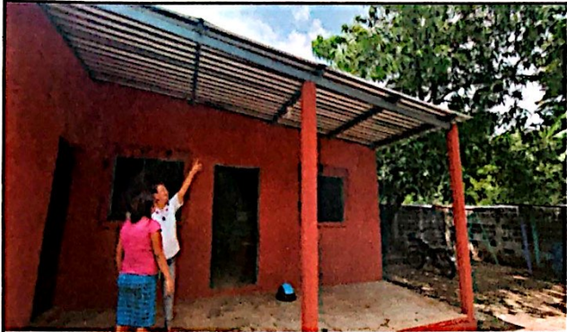
Foto1: Suministro e instalación de lamina troquelada aluzinc calibre 26 finalizado al 100%.
