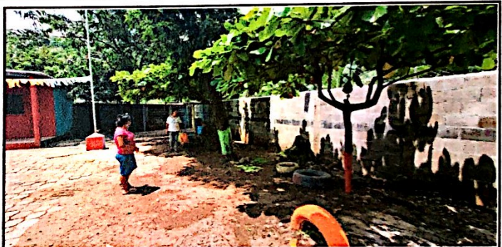
Foto 4: Directora y OPF entregan al 100% la Sustitución de muro perimetral prefabricado por muro de block 15 cm x 20 cm x 40 cm.
