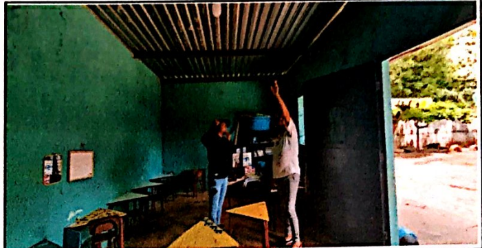
Foto 2: Evaluadora supervisa el 100% de Mejoramiento de estructura de metal, incluye fijado y pintura anticorrosiva.
