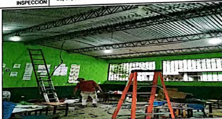
Foto 8: Se muestran los trabajos de mejoramiento y suministro de las instalaciones eléctricas (iluminación y fuerza) en salones de clases.
