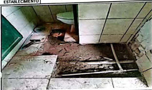
Foto 7: Trabajos de remozamiento y mejoras en el módulo de baños donde se planea la instalación de un inodoro para niños pequeños.
