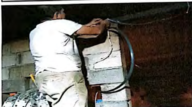
Foto 9: Se muestran los trabajos de mejoramiento y suministro de las instalaciones eléctricas (iluminación y fuerza) en bodega y guardiana.
