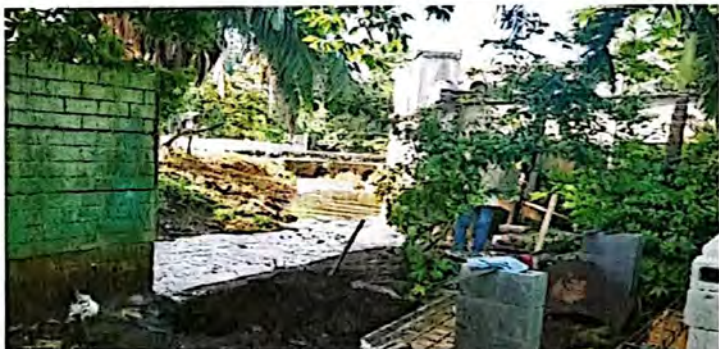
Foto 12: Sección de muro perimetral prefabricado que debe ser sustituido con un muro de block que incluye soleras y columnas.
