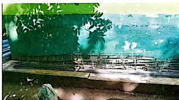
Foto 11: Fabricación de soleras y columnas de concreto para utilizarlo en el muro perimetral de block.
