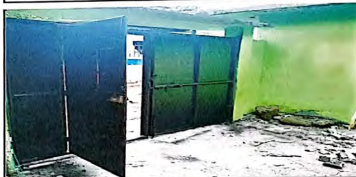
Foto 10: Mantenimiento y reparación del porton principal de la escuela. Se encuentra en ejecución y ajustes.
