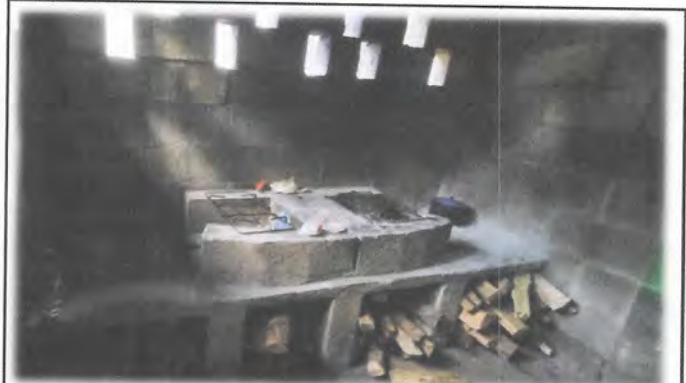
Foto 3: Mejoramiento de cocina, incluye remozamiento de estufa de leña rural, muebles fijos de concreto, y azulejo .
