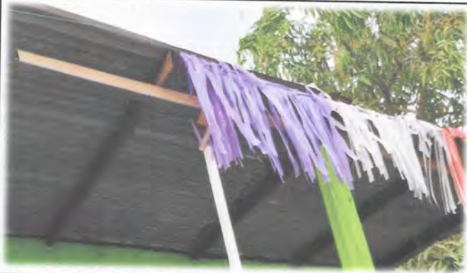
Foto 9: Cambio e Instalación de estructura de metal, lincluye lijado y pintura anticorrosiva en el módulo de salón individual.
