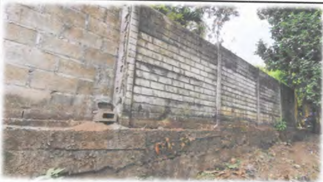
Foto 11: Muro perimetral prefabricado del Centro de Educación Integral.
