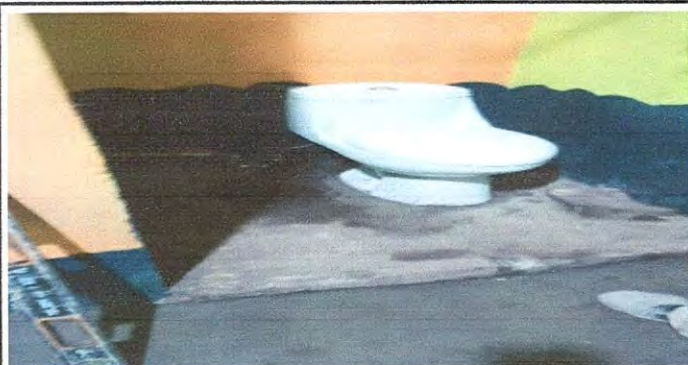
Foto 7: Sustitución Inodoro. Dirección.
