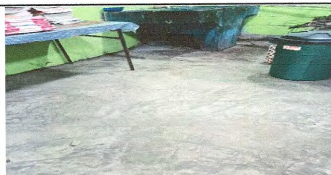
Foto 17: Sustrucción de tubería PVC línea principal aguas negras.
