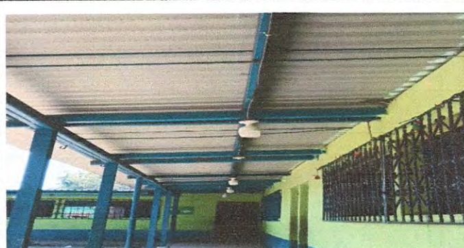
Foto 14: Instalación de unidades luz ( incluye interruptor, ducto y cable eléctrico) corredor de la escuela.
