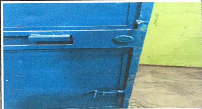
Foto 4: Sustitución de chapa en puerta de la cocina.
