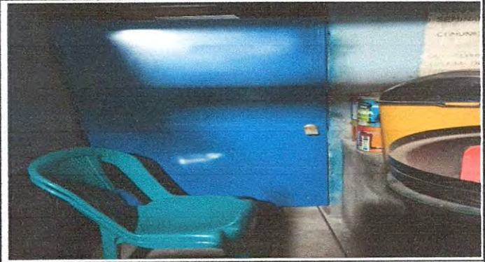
Foto 2: Sustitución de puerta en la bodega de la cocina. Con chapa.
