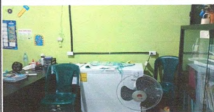
Foto 16: Sustrucción de tomacorrientes dobles. Dirección.
