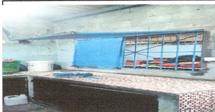
Foto13: Sustrucción de estructura de metal de ventana. De la cocina.
