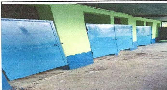
Foto 3: Mantenimiento a estructura ( lijado, cambio de tubo, cepillado, sujeciones, aplicación de pintura) a 6 puertas sevicios sanitarios de alumnos.
