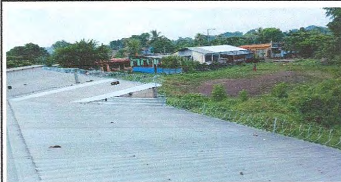
Foto 8: Instalación de 60 metros lineales de cerdo tipo Razor perímetro afuera de la escuela.
