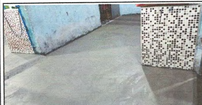
Foto 5: Reparación de piso de torta de concreto.
