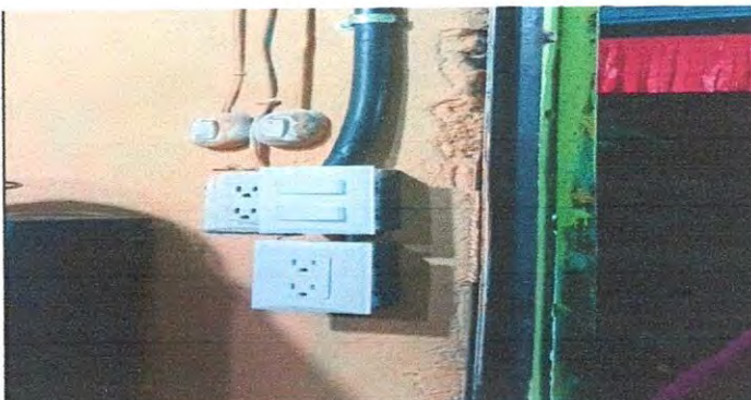
Foto 11: Sustitución de interruptores simples.
