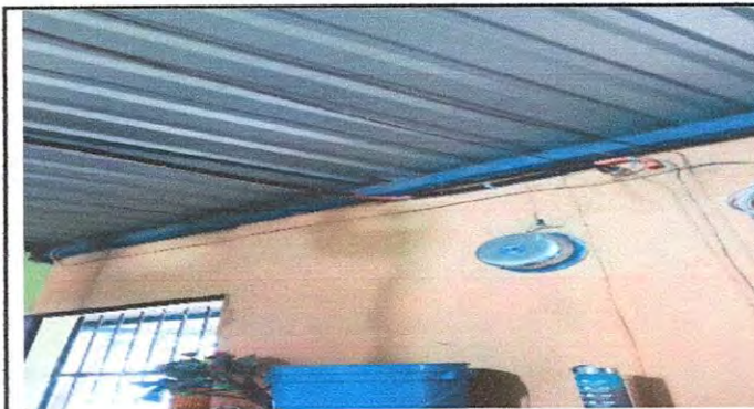
Foto 10: Reparación de cableado eléctrico dirección y cocina.
