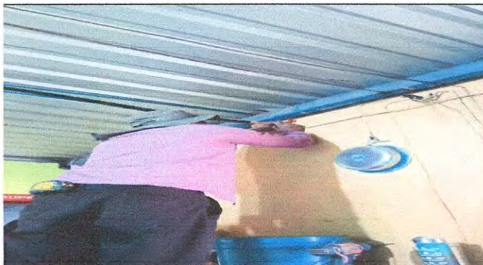
Foto 10: Reparación de cableado eléctrico dirección y cocina.
