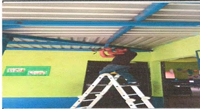
Foto 14: Instalación de unidades luz (incluye interruptor, ducto y cable eléctrico) corredor de la escuela.
