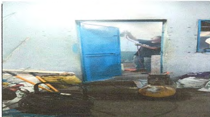
Foto 4: Sustitución de Chapa en puerta de cocina.
