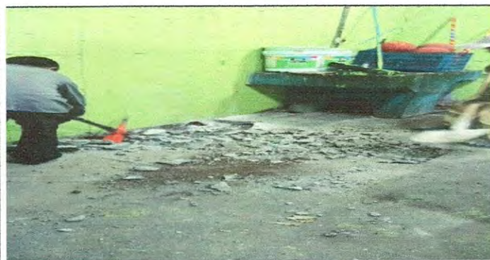
Foto 5: Reparación de piso de torta de concreto.
