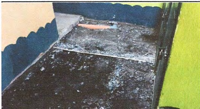
Foto 7: Sustrucción Inodoro. Dirección
