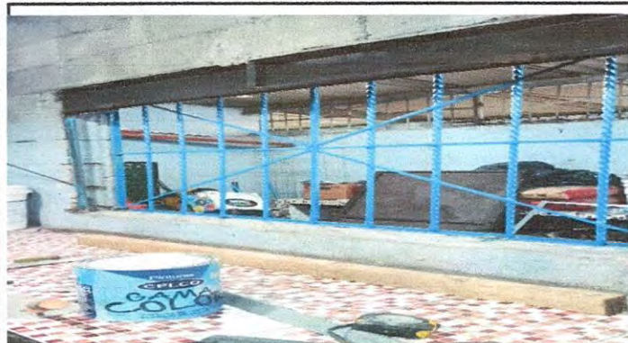
Foto 13: Sustrucción de estructura de metal de ventana. De la cocina.
