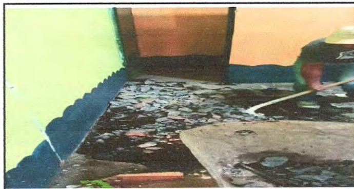
Foto 6: Reparación de piso de cemento liquido en una parte de la dirección .
