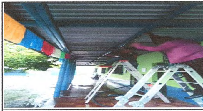
Foto 12: Instalación de unidades luz( incluye interruptor, ducto y cable eléctrico. Corredor de los salones.
