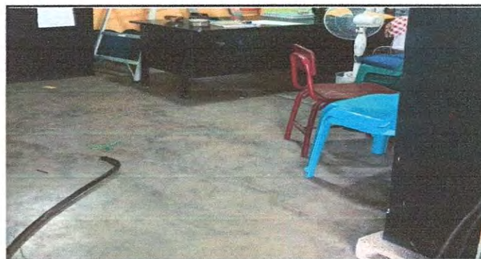
Foto 18: Reparacion de piso de torta de concreto en la direccion.
