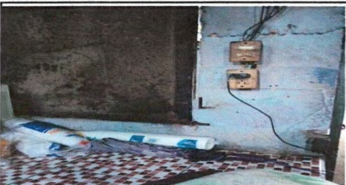
Foto 9: Sustrución de interruptores y apagadores en la cocina.
