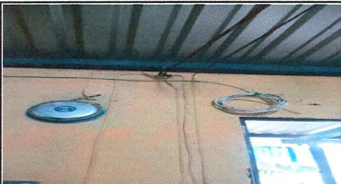
Foto 10: Reparación de cableado electrico dirección y cocina .
