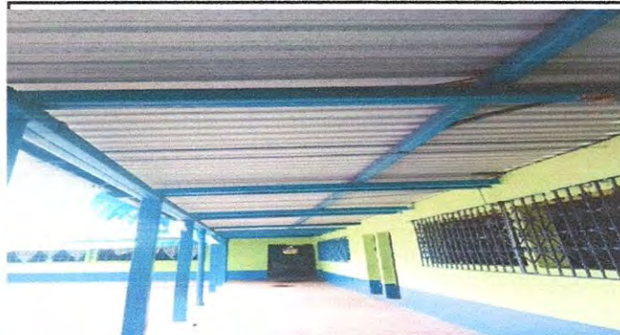
Foto 14: Instalacion de unidades luz 8(incluye interruptor, ducto y cable electrico) corredor de la escuela
