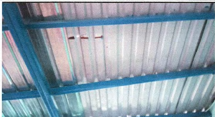
Foto1: Sutipcion de lamina, por lamina troquelada aluzinc calibre 26 aula No. 06
