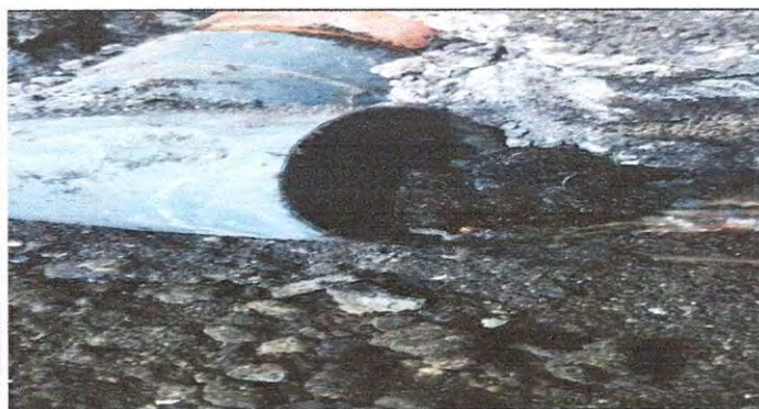
Foto 17: Sustrucion a tuberia PVC linea principal aguas negras.
