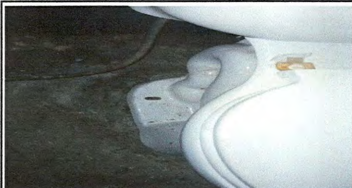
Foto7: Sustrución Inodoro. Dirección
