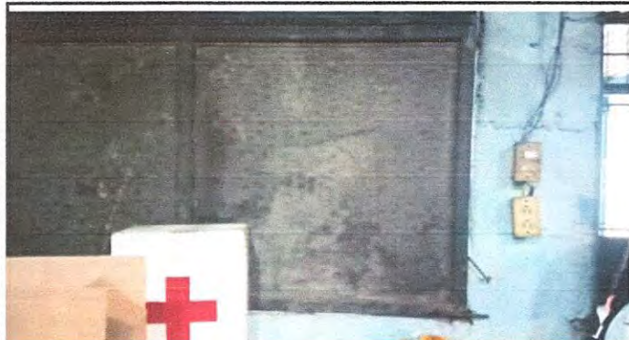
Foto13: Sustrucion de estructura de metal de ventana. De la cocina
