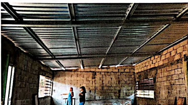
Foto 9: Cambio e instalación de lamina, por lamina troquelada aluzinc calibre 26 (incluye tornillos) en el módulo de bodega, finalizado al 100%.
