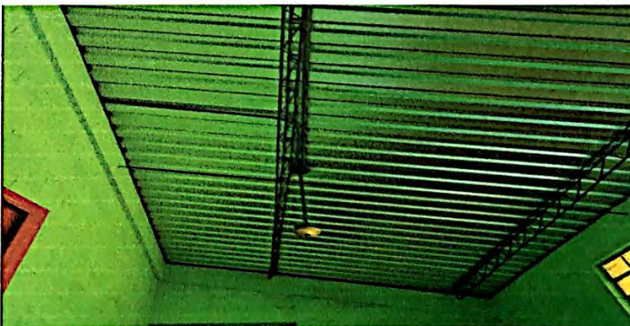
Foto 6: Cambio e instalación de lamina, por lamina troquelada aluzinc calibre 26 (incluye tornillos) en la cocina del 2do. Módulo de aulas, finalizado al 100%.
