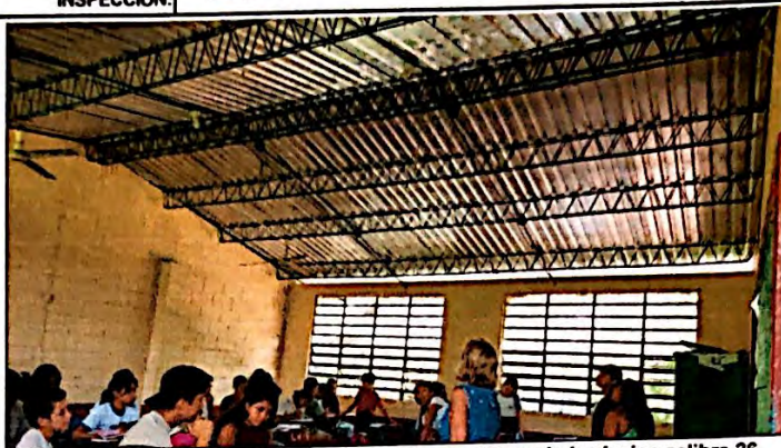
Foto 2: Cambio e instalación de lamina, por lamina troquelada aluzinc calibre 26 (incluye tornillos) en aula del 1er. Módulo de aulas, finalizado al 100%.
