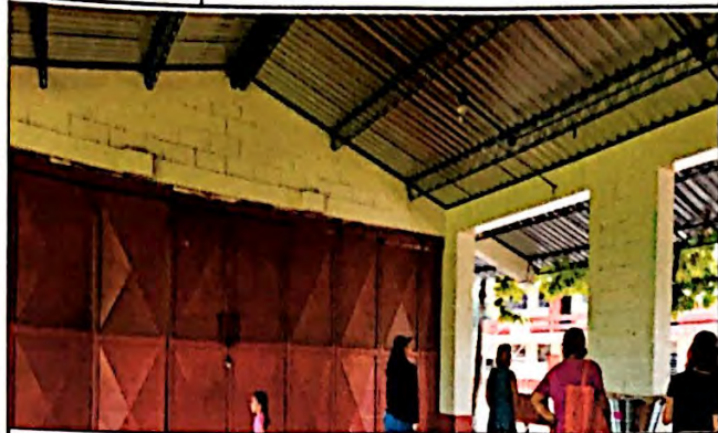
Foto 7: Cambio e instalación de lamina, por lamina troquelada aluzinc calibre 26 (incluye tornillos) en el 2do. Módulo de aulas, finalizado al 100%.
