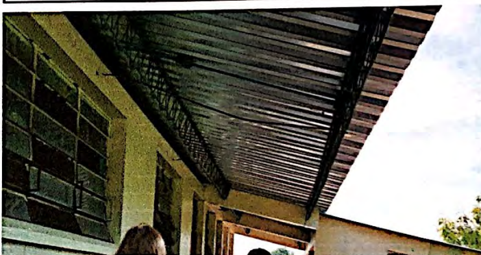
Foto 4: Cambio e instalación de lamina, por lamina troquelada aluzinc calibre 26 (incluye tornillos) en pasillo exterior del 1er. Módulo de aulas, finalizado al 100%.
