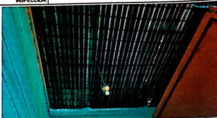
Foto 8: Cambio e instalación de lamina, por lamina troquelada aluzinc calibre 26 (incluye tornillos) en el 2do. Módulo de aulas (se observa la protección anti robos en la bodega, debajo de la nueva lámina) finalizado al 100%.
