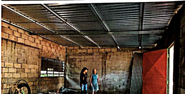
Foto 10: Cambio e instalación de lamina, por lamina troquelada aluzinc calibre 26 (incluye tornillos) en el módulo de bodega, finalizado al 100%.
