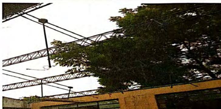
Foto 10: 2do módulo de aulas más dirección en el procedimiento de desmontaje de láminas para luego continuar el proceso con la sustitución de estas.
