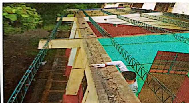
Foto 9: 2do módulo de aulas más dirección en el procedimiento de desmontaje de láminas para luego continuar el proceso con la sustitución de estas.
