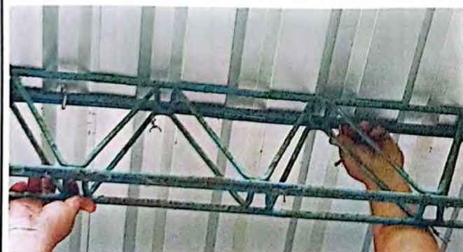
Foto 11: Cambio e instalación de lámina, por lámina troquelada aluzinc calibre 26 (incluye tornillos). Se observa el proceso de fijación de las primeras láminas en el 2do módulo de aulas más dirección.
