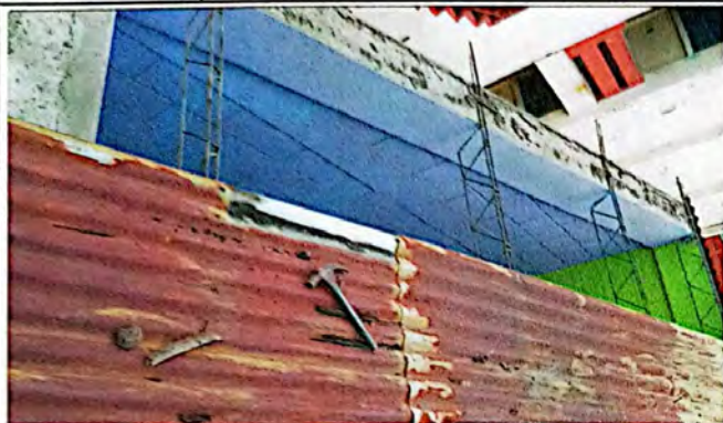
Foto 7: Cambio e instalación de lamina, por lamina troquelada aluzinc calibre 26 (incluye tornillos). Se observa el proceso de desmontaje en el 2do módulo de aulas más dirección del establecimiento.
