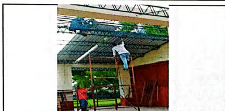
Foto 12: Se observa el andamiaje necesario para el transporte de las láminas de nivel de suelo hasta el techo del 2do módulo de aulas más dirección.
