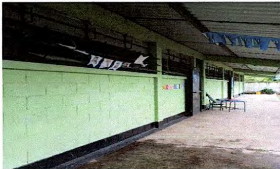
Foto 5: Sustitución de balcones de metal
