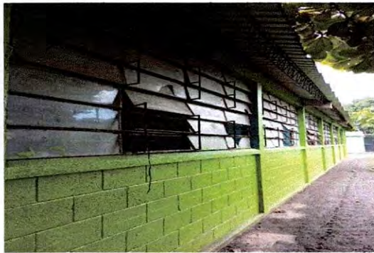
Foto 3: Sustitución de estructura de metal de Ventana
