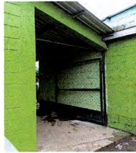
Foto 4: Sustitución de porton de metal
