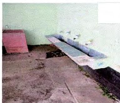
Foto 6: Sustitución de lavamanos
