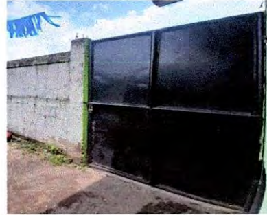
Foto 2: Sustitución de porton de metal
