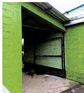
Foto 4: Sustitución de porton de metal
