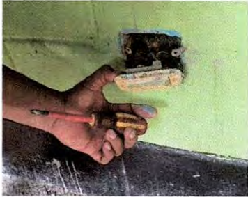
Foto1: Sustitucion de tomacorrientes dobles
