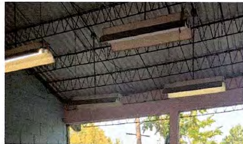
Foto 2: Sustitución de Lámparas
