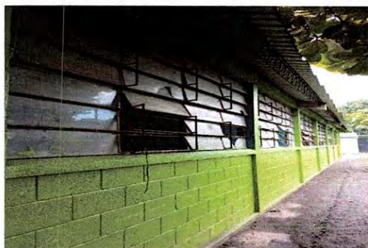
Foto 3: Sustitución de estructura de metal de Ventana
