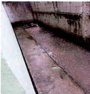
Foto 3: Sustitución de Cemento Liquido
