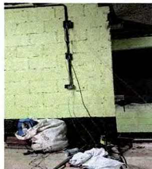
Foto 4: Sustitucion de interruptores dobles
