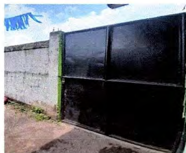
Foto 2: Sustitución de porton de metal
