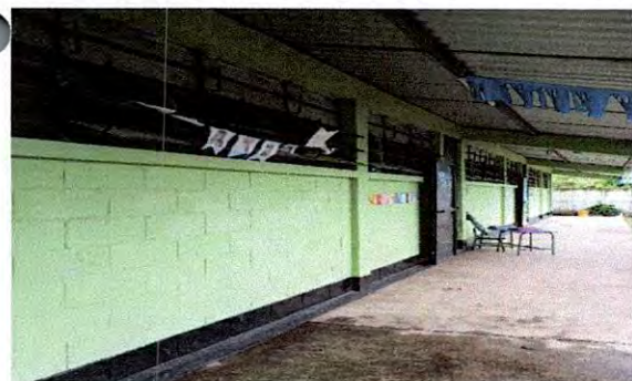
Foto 5: Sustitución de balcones de metal
