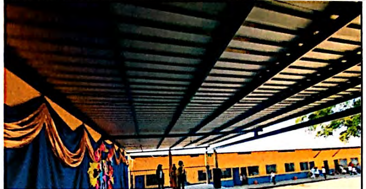
Foto 8: Área de escenario, suministro e instalación de lámina troquelada Aluzinc calibre 26 (incluye tornillos), finalizado al 100%
