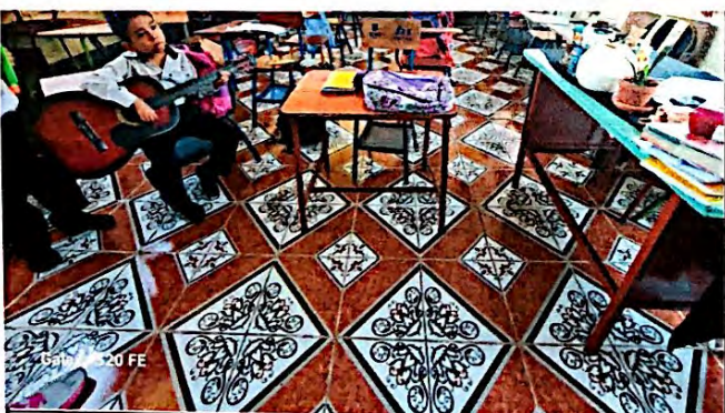
Foto 11: Cambio e instalación de piso cerámico en módulo de aulas, finalizado al 100%
