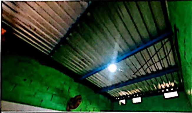
Foto 7: Módulo de cocina, cambio e instalación de lámina troquelada aluzinc calibre 26. Incluye tornillos, finalizado al 100%
