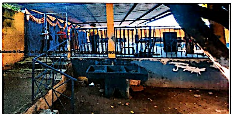
Foto 10: Puerta tipo reja y barandal en área del escenario finalizada al 100%
