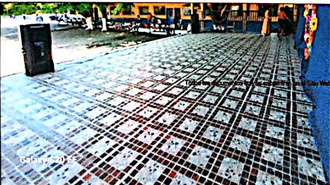
Foto 9: Cambio e instalación de piso en el área del escenario finalizada al 100%
