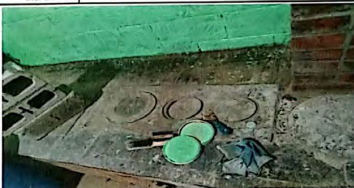
Foto 8: Módulo de cocina en proceso de avance, se contempla el avance la reparación de la plancha metálica de la estufa de leña rural. Ejecución en proceso constructivo.
