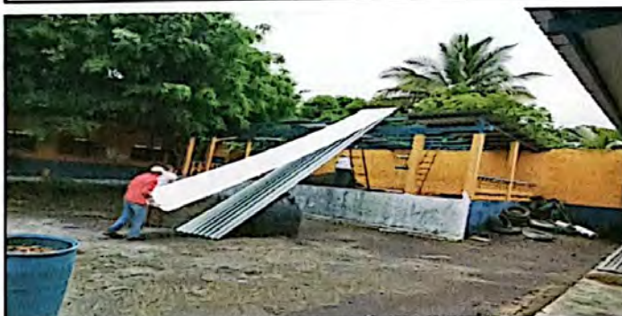
Foto 10: Avance de instalación de lamina troquelada aluzinc calibre 26 sobre la estructura metálica portante que ya ha recibido su mantenimiento que incluye lijado y pintura. En el área de escenario.
