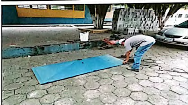
Foto 9: Herrería, se observó avance en el mantenimiento de las puertas metálicas. Ejecución en proceso constructivo.
