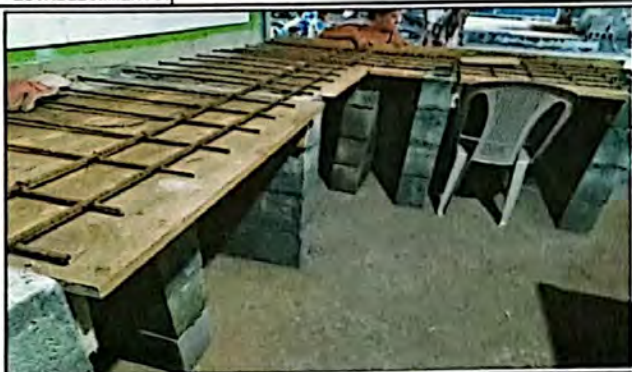
Foto 7: Módulo de cocina en proceso de avance, se contempla el avance de fabricación de muebles fijos. Ejecución en proceso constructivo.
