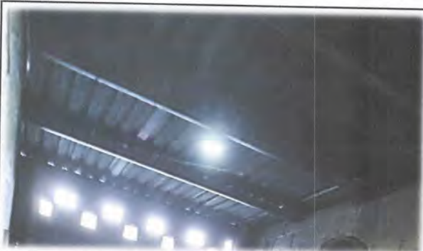
Foto 9: Mantenimiento e instalación de estructura de metal, incluye lijado, pintura anticorrosiva y cambio e instalación de lámina troquelada aluzinc calibre 26. incluye tornillos.
