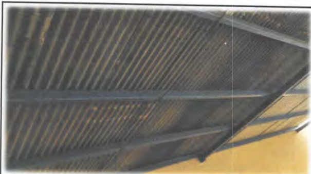
Foto 11: Es necesario el suministro e instalación de lámina troquelada Aluzinc calibre 26 (incluye tornillos) en el módulo del escenario.
