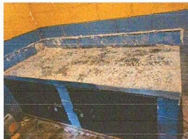
Foto 8: Reparación de azulejo en muebles de cocina
