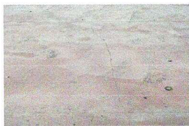
Foto 5: Sustitución de piso
