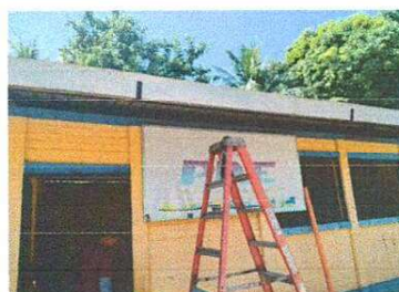
Foto 6: Sustitución de canal de metal
