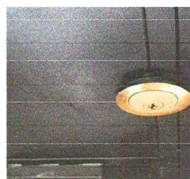
Foto 2: Sustitución de chapa
