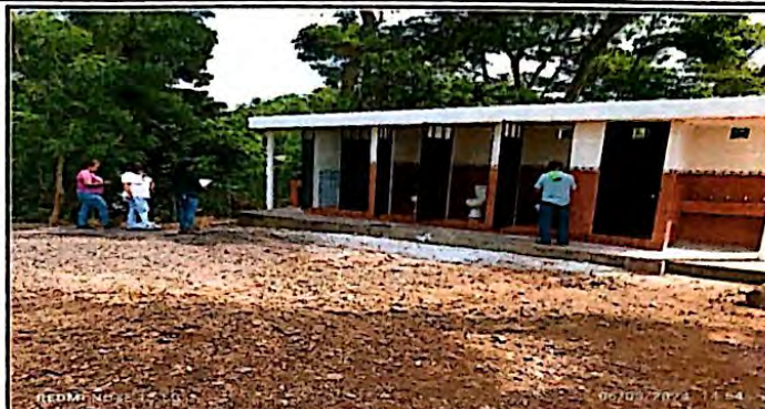
Foto 2: Se inicia con la evaluación del modulo del servicio sanitario.
