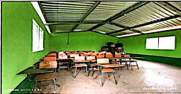
Foto 8: Mejoramiento de muro divisor de dos aulas con un sistema constructivo de mamposteria reforzada finalizado al 100%.
