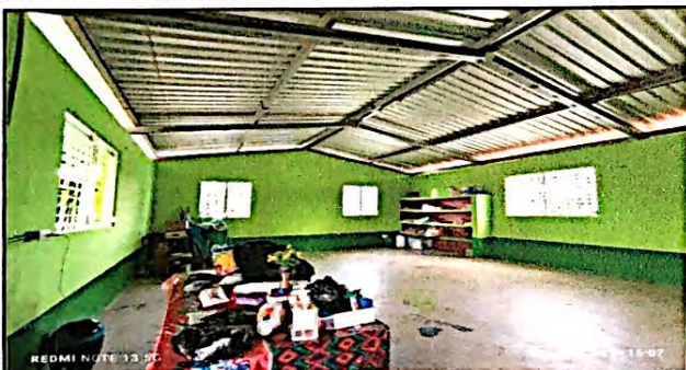
Foto 9: Instalación de ventanas de aluminio mill finish mas paleta de vidrio en modulo de aulas al 100%.
