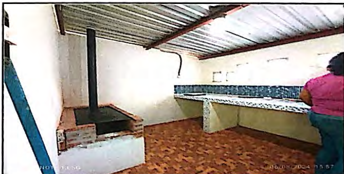
Foto 6: Reparación de muebles fijos de concreto mas instalacion de azulejo y piso ceramico antideslizante al 100%.
