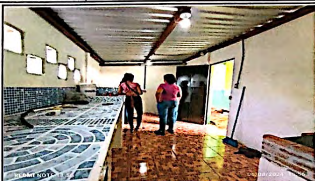
Foto 7: Se sustituye en el modulo de cocina el piso ceramico antideslizante obteniendo el 100% de su ejecución.
