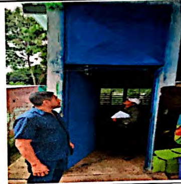
Foto 8: Reparación y mantimientio en puerta de metal del salón de clases. Fianlizado
