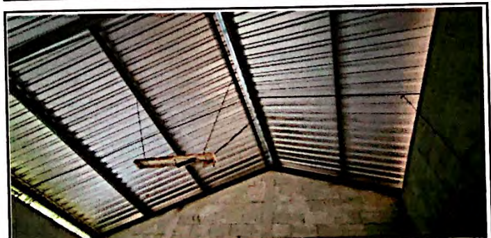
Foto 12: Instalación de lamina troquelada aluzinc calibre 26 y mantenimiento en estructura en modulo de aulas lado NORESTE INTERIOR. Trabo adicional finalizado.
