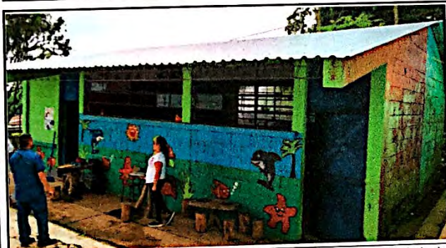
Foto 9: Modulo de dirección con salon de clases, Donde se recibo el trabajo de cambio de lamina troquelada aluzinc calibre 26 y mantenimiento en su estructura metalica tipo Joins.
