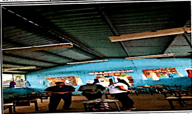
Foto 7: Instalación de lamina troquelada aluzinc calibre 26 y mantenimiento de estructura de metal, incluye lijado y pintura anticorrosiva en el modulo de aula juntamente con servicios sanitarios. Finalizado
