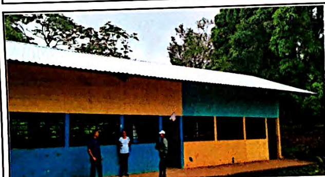
Foto 11: Se logró con la buena gestión un trabajo adicional llamado de otra manera remanente, la instalación de lamina troquelada aluzinc calibre 26 y mantenimiento en estructura en modulo de aulas lado NORESTE EXTERIOR.
