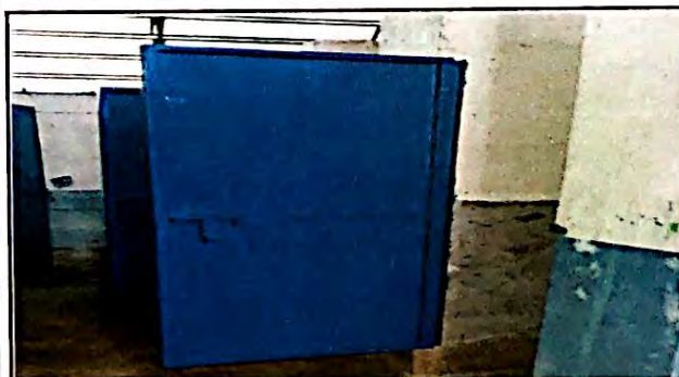
Foto 5: Trabajo de mejoramiento de herrería, incluye lijado y pinturas en puertas de cada cubículo de los inodoros.
