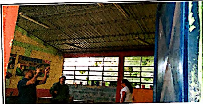
Foto 10: Presidente de OPF entrega el trabajo de cambio e instalación de lamina troquelada aluzinc calibre 26 a evaluadora de campo, el modulo de dirección mas salon de clases, finalizado.
