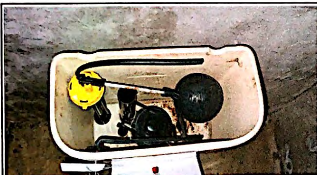
Foto 3: Presidente de OPF, expone a la evaluadora de cambio la colocación de nuevos kits de servicios sanitarios, finalizado al 100%.
