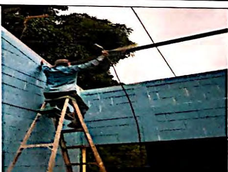
Foto 12: Mantenimiento en estructura de metal para la cubierta en proceso de avance. En el modulo de aulas, trabajo adicional.
