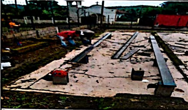
Foto 7: Mantenimiento en estructura de metal para la cubierta en proceso de avance. Para el modulo de servicios sanitarios mas salón de clases.
