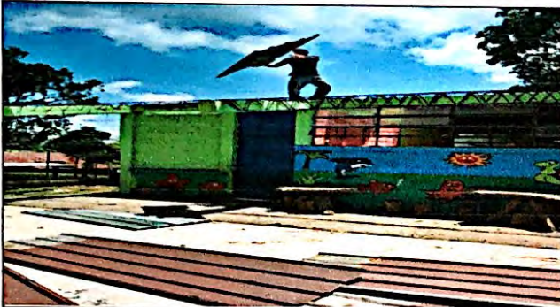
Foto 9: También se puede observar el avance en el siguiente modulo de trabajo (dirección mas salon de clases). El desmontaje de lamina en mal estado.
