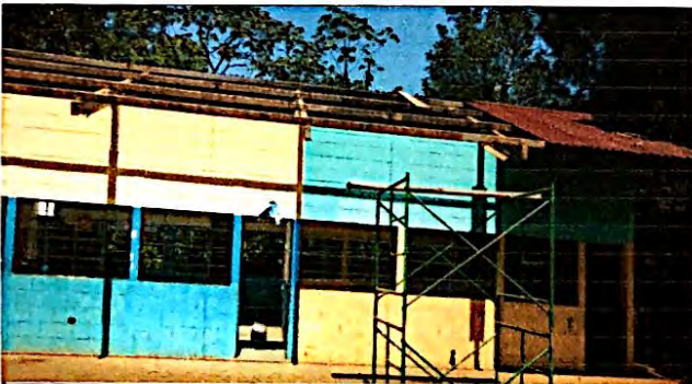
Foto 11: Por la buena gestión de OPF y supervisora se logra un trabajo adicional de la PRA-FOR-85. El desmontaje de lamina en mal estado, en el modulo de aulas lado Norte del establecimiento.
