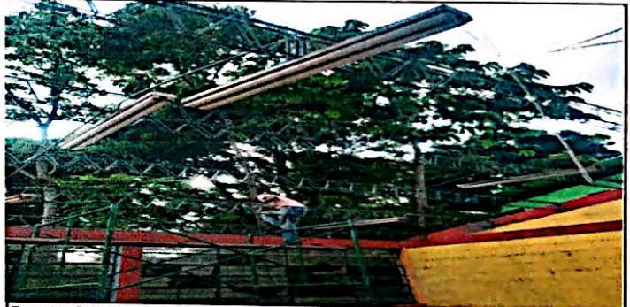
Foto 10: Se inicia el mantenimiento de estructura de metal tipo JOIST. En modulo de (dirección mas salon de clases).
