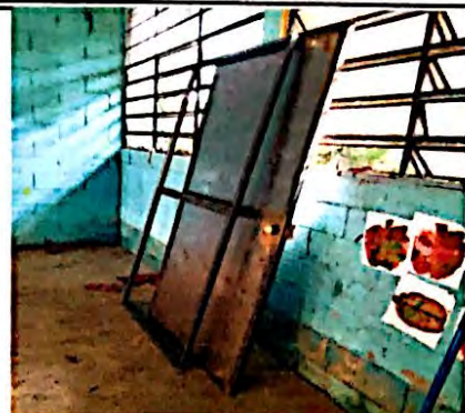
Foto 8: Sustitución de puerta de metal en el salon de clases, aun costado de los servicios sanitarios. En proceso de instalación.
