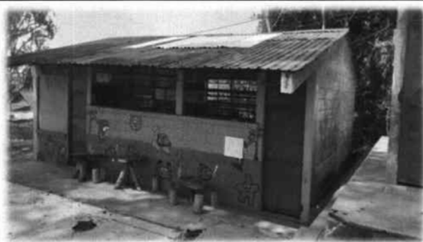
Foto 7: Cambio e instalacion de lamina troquelada aluzinc calibre 26, del modulo de dirección y un aula. Exterior.
