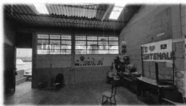
Foto 9: Cambio e instalacion de lamina troquelada aluzinc calibre 26, del modulo de dirección y un aula. Interior.
