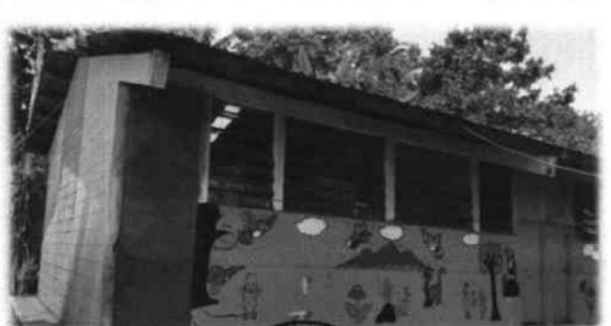
Foto 11: Cambio e instalacion de lamina troquelada aluzinc calibre 26, del modulo de un aula y servicios sanitarios. Exterior.
