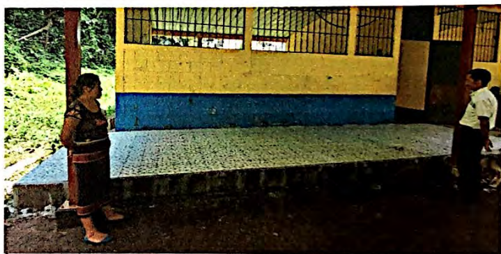
Foto 10: Cambio e instalación de piso antideslizante en el corredor del módulo de aulas que es usado como escenario, finalizado al 100%.
