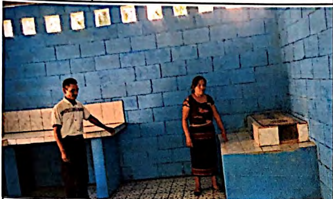
Foto 7: Mejoramiento de modulo de cocina, incluye remozamiento de estufa de leña rural, azulejo, finalizado al 100%.
