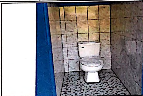
Foto 2: Reparación y mejoramiento de servicios sanitarios, incluye reparaciones, cambio de tubería, artefactos y muebles fijos de concreto (migatorio) y azulejo. Finalizado al 100%.
