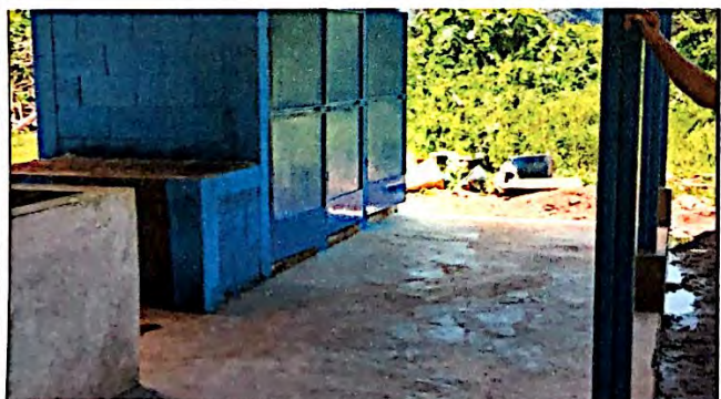
Foto 5: Cambio e instalación de piso torta de concreto finalizado al 100%.
