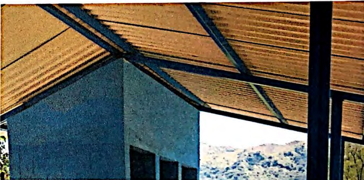
Foto 4: Cambio e instalación de estructura de lamina por lamina troquelada aluzinc calibre 26, incluye capote y tornillos en el módulo de servicios sanitarios, finalizado al 100%.
