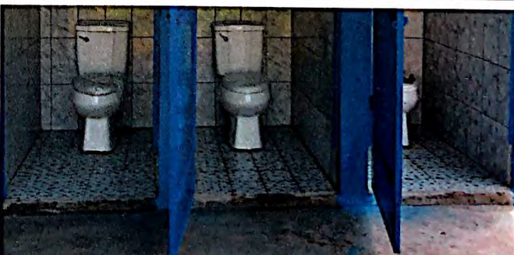
Foto 6: Cambio e instalación de piso antideslizante en los servicios sanitarios, finalizado al 100%.
