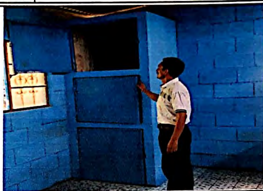
Foto 8: Mejoramiento de modulo de cocina, incluye muebles de concreto fijo, finalizado al 100%.
