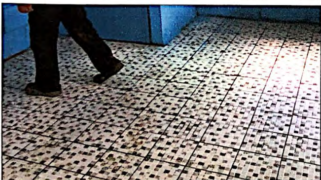
Foto 9: Cambio e instalación de piso antideslizante en el módulo de cocina, finalizado al 100%.
