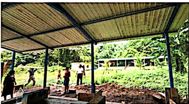
Foto 3: Cambio e instalación de estructura de metal en el módulo de servicios sanitarios, finalizado al 100%.
