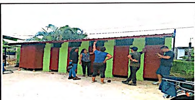
Foto 3: Mejoramiento en el modulo de servicios sanitarios, cambio de lamina troquelada aluzinc calibre 26 finalizado al 100% de su ejecución.
