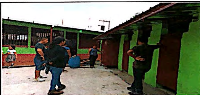
Foto 4: Se observa mejoramiento donde incluye lijado, pintura y reparaciones en puertas en el modulo de servicios sanitarios.
