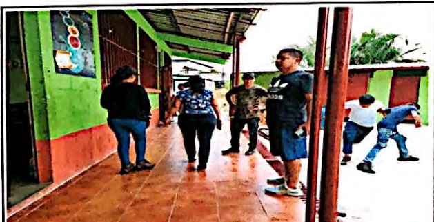
Foto 5: Se continua el recorrido para la recepción del remozamiento al 100% de su ejecución.
