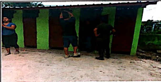
Foto 2: Mejoramiento en el modulo de servicios sanitarios, sustitución de estructura metálica para el modulo de servicio sanitarios.
