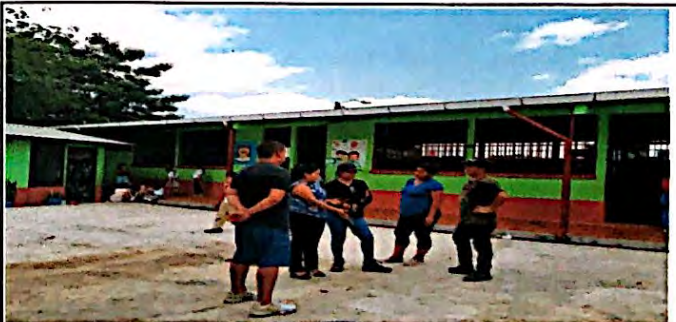
Foto 6: Reparación y mejoramiento de losa de patio finalizado al 100% de su ejecución.
