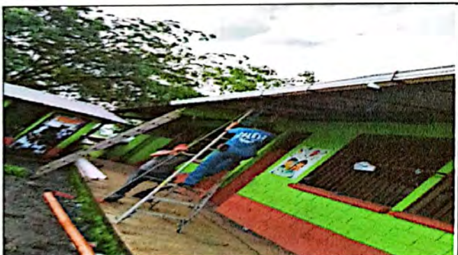
Foto 9: Seguimiento de supervisión de remozamiento en proceso de ejecución.
