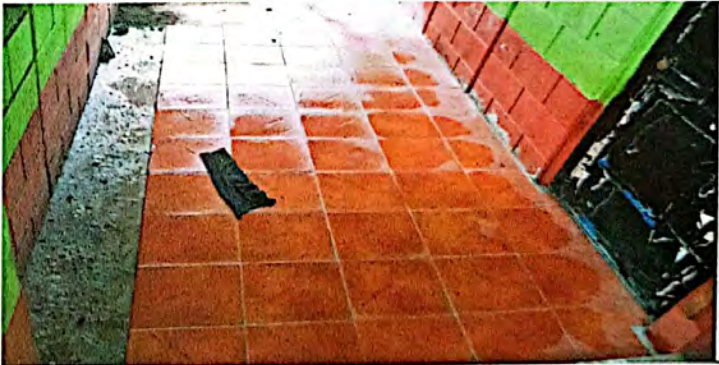
Foto 10: En el renglón 4.1 según PRA-FOR-85, cambio e instalación a piso antideslizante.
