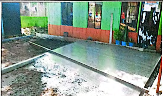
Foto 7: Se logra ver el avance de la fundición de losa de patio. Proceso en ejecución.
