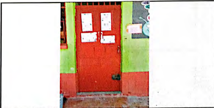
Foto 12: Pasadores de puertas ya instalados en algunas de ellas. Cabe mencionar que es un trabajo adicional a la PRA-FOR-85.
