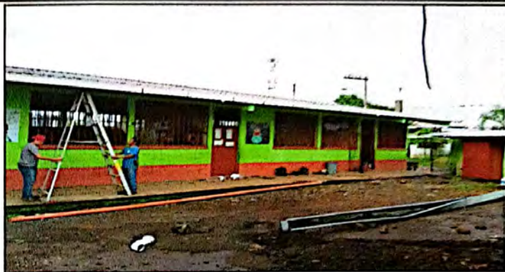
Foto 8: Cambio e instalación de canal pvc mas soporte de metal para el mismo canal. Según renglón 3.1 y 3.2 según PRA-FOR-85. Proceso en ejecución.
