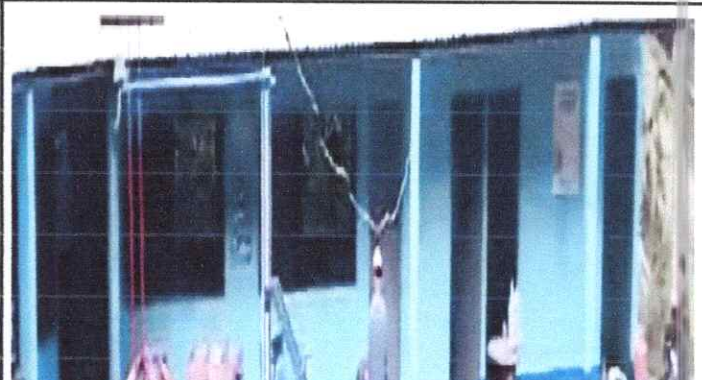
Foto 14: PINTURA EN MUROS EXTERIORES E INTERIORES
