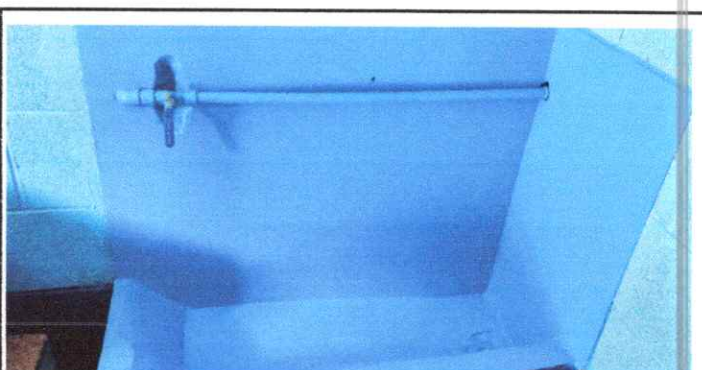
Foto 18: SUSTITUCIÓN DE LLAVE EN MINGITORIO
